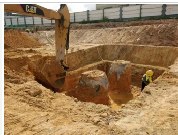
挖槽施工现场
