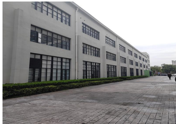
(d) 北侧-园区内 E 栋楼
