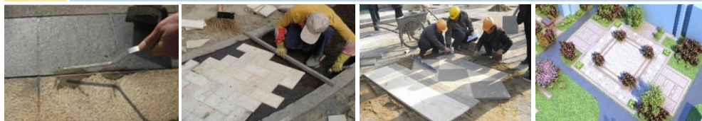
防止出现空鼓 铺贴应倒退进行 试铺区、样板先行 铺装效果图
