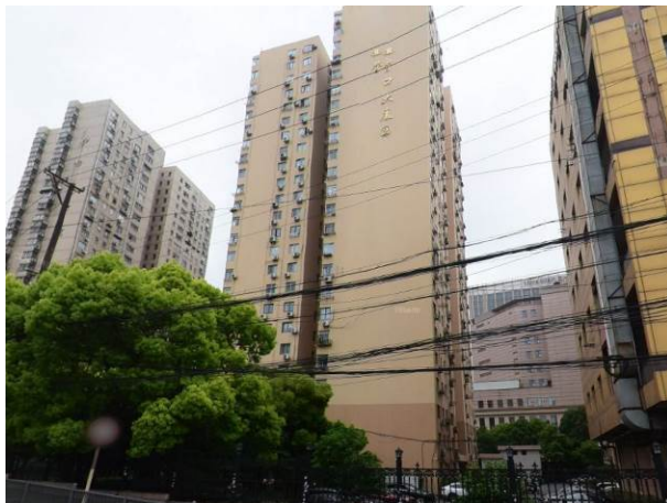
建筑南侧营口大厦 2 幢
