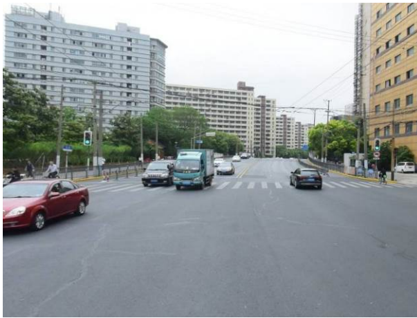
建筑东侧营口路
