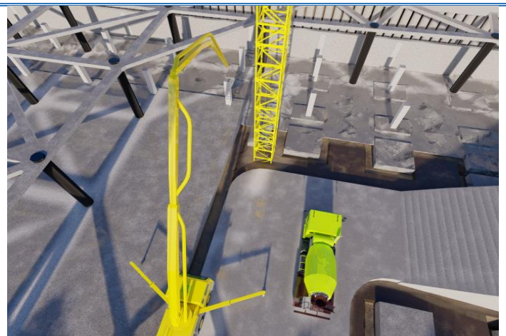
混凝土浇筑模拟
