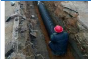
波纹管管道施工
