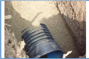
波纹管四周回填砂
