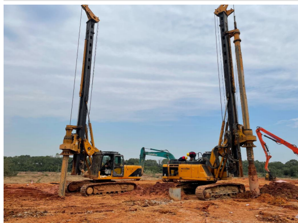
旋挖灌注桩施工
