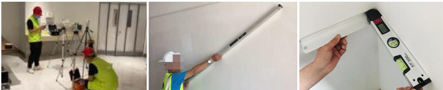
室内环境检测 墙面平整度检验 墙面阴阳角检验
