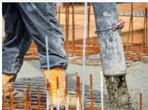
混凝土浇筑
