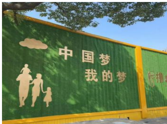
临时围墙建设
