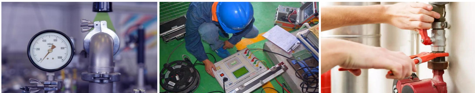
管道试压试验 绝缘性能检验 管道通水试验
