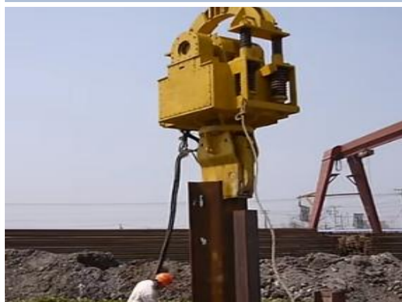
H+HAT工法桩施工
