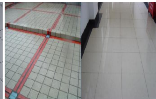
分隔缝油膏嵌填密实顺直
