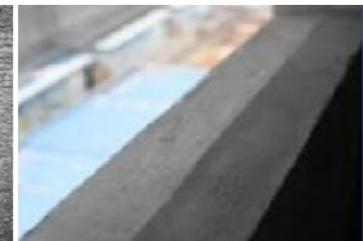
门窗洞口塞缝处理
