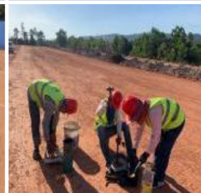
路基压实度检测
