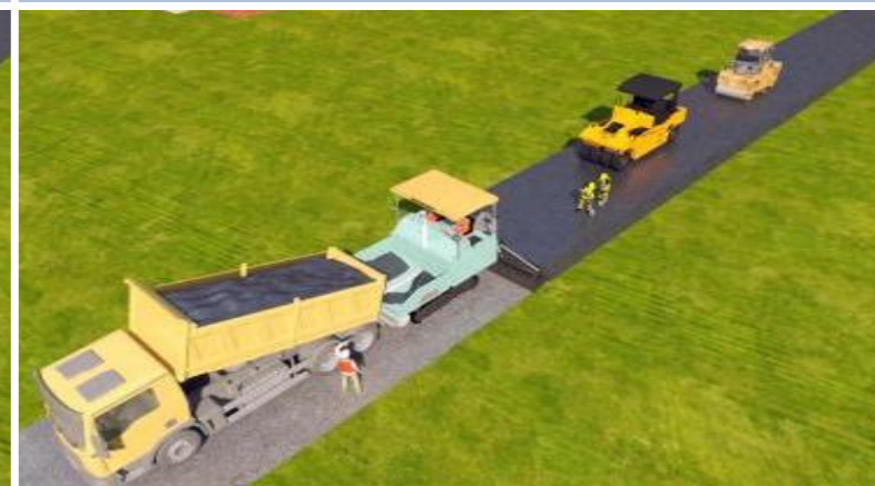
沥青上面层施工
