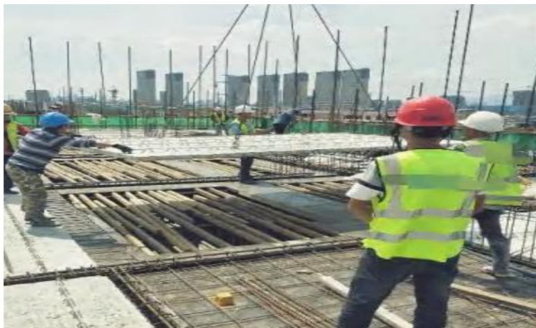
起重吊装旁站
