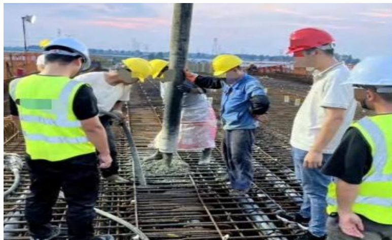
混凝土浇筑旁站
