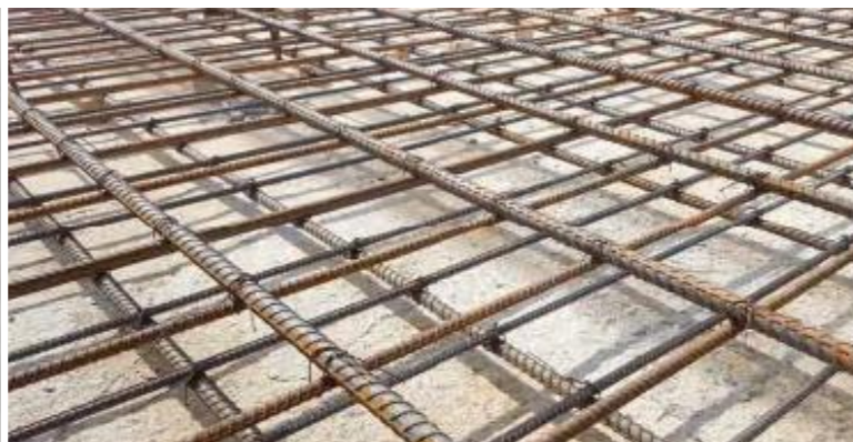
楼板钢筋绑扎
