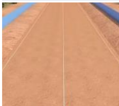
填筑完成恢复边线
