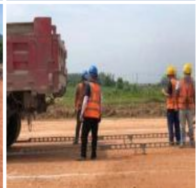
路基弯沉检测
