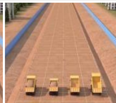
路堤填筑画格上土
