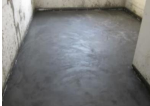
水泥砂浆楼面完成效果图
