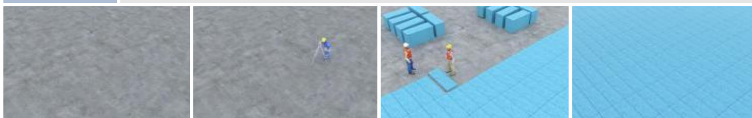
基层处理 测量放线 粘贴挤塑聚苯板 完成效果
