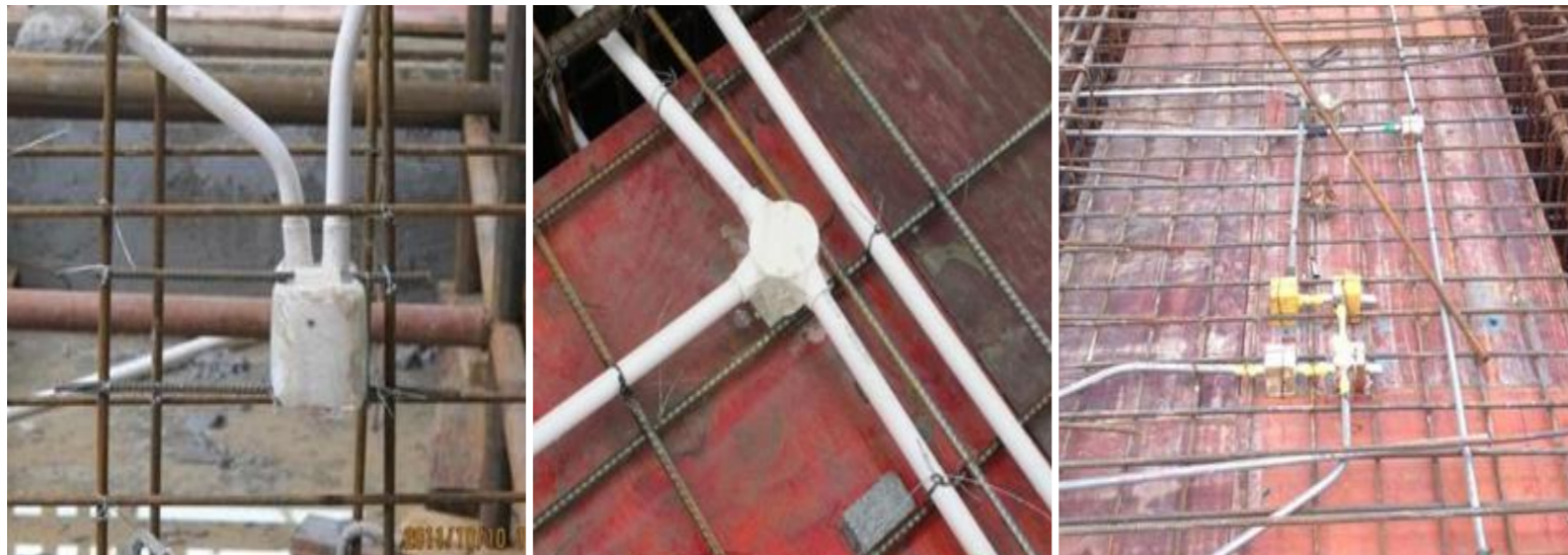
预埋件 楼面预埋 浇筑混凝土 混凝土预埋件
