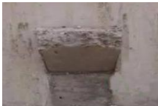
墙面洞口混凝土封堵
