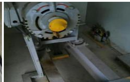
⑥电气设备安装工艺
