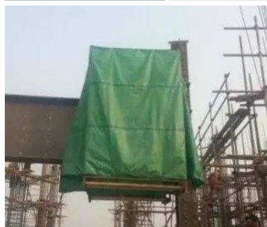
焊接防护措施
