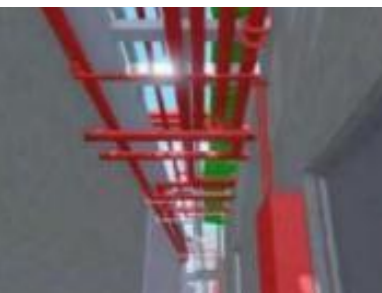
消防管道施工
