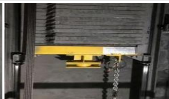
②对重、轿厢安装
