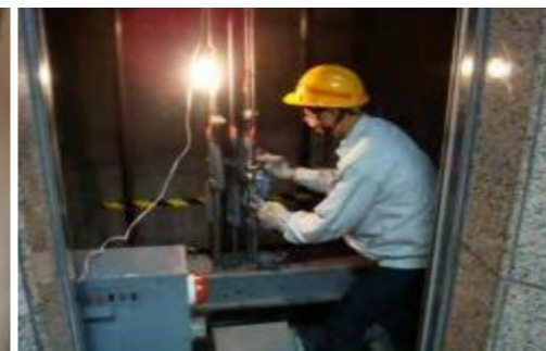
④井道机械设备安装
