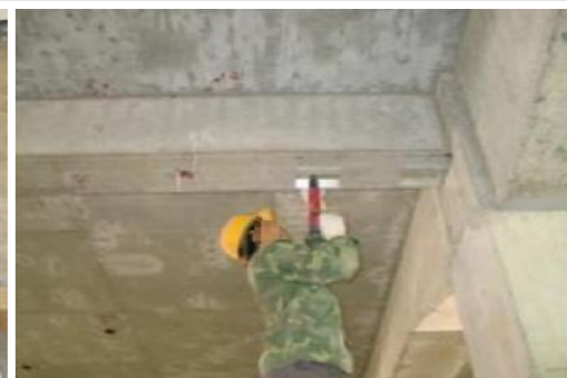
U型定位卡扣安装
