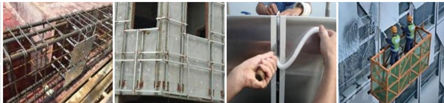
预埋件安装 铝板龙骨架示例 打胶前嵌泡沫棒 淋水试验
