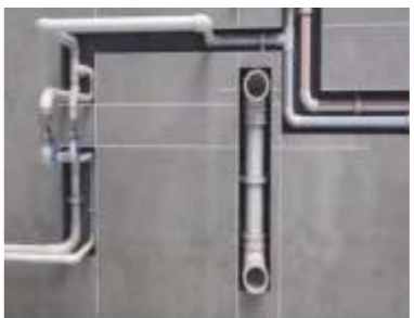
给水管道安装
