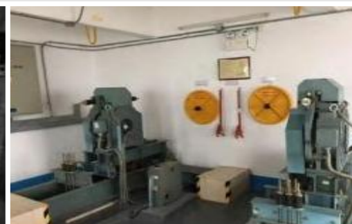
③机械设备安装
