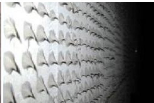
混凝土墙面甩浆
