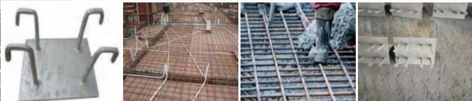
预埋件 楼面预埋 浇筑混凝土 混凝土预埋件
