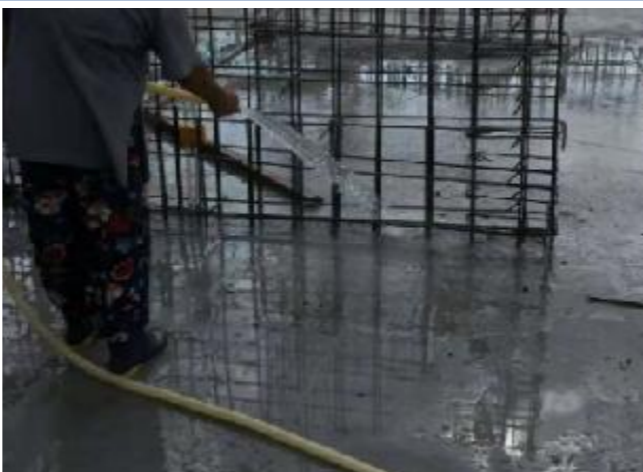
板面浇水养护
