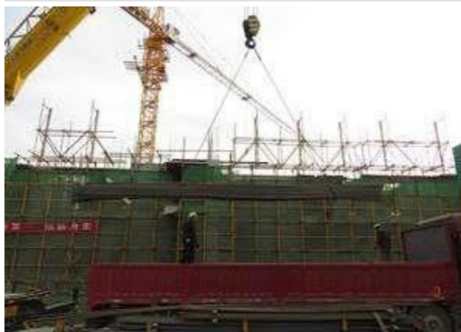
钢筋吊运：用塔吊或汽车吊运输钢筋时，对较长的钢筋应进行试吊。
