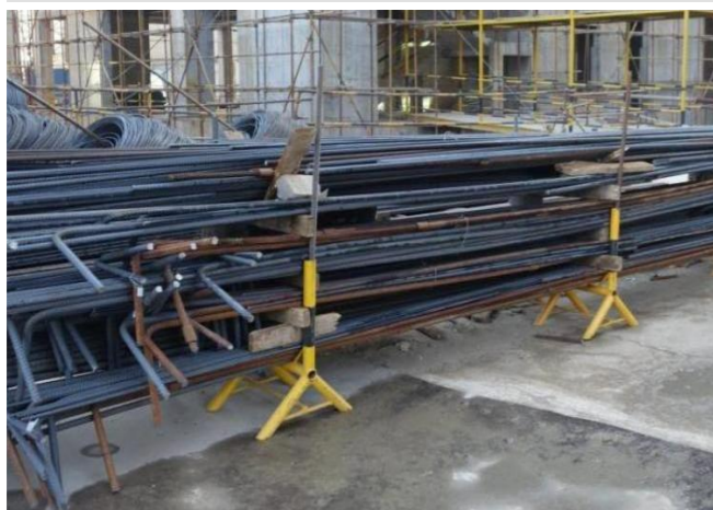
钢筋半成品堆放：按照公司标准化要求设置钢筋堆放支座。
