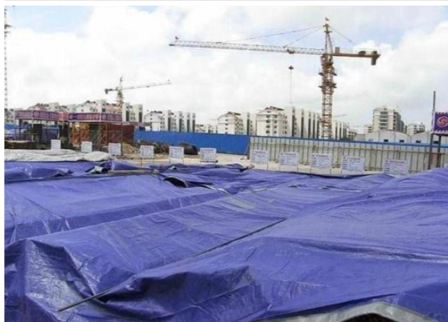
钢筋长时间不用或阴雨天气时，覆盖塑料布，防止钢筋生锈。
