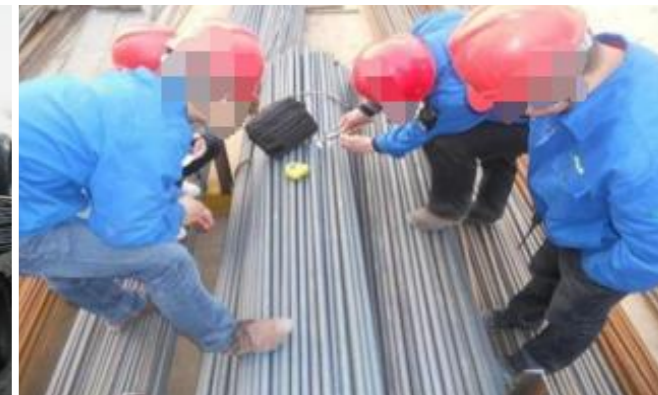
钢筋应进行外观检测，应平直、无损伤、无扭曲表面不得有裂纹、油污、颗粒状或片状老锈。
