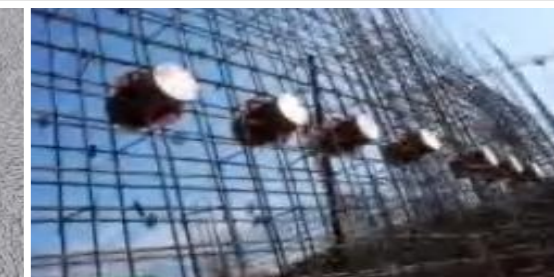
埋管止水环埋设
