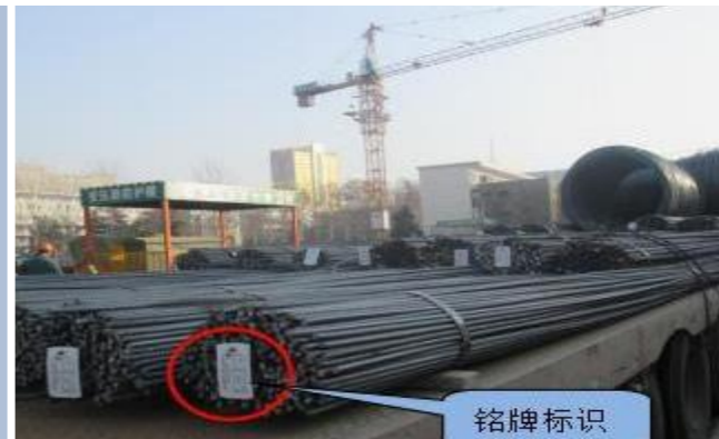
钢筋进场卸货前，检查出厂合格证、检测报告、钢筋标识牌、钢筋上的标识，所标注的供应商名称、牌号、炉号（批号）、型号、规格、重量等。
