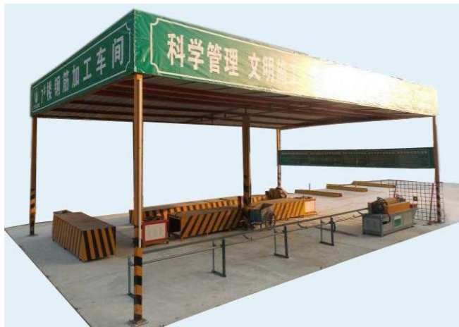
操作平台：钢筋加工操作平台采用模板进行封闭，涂刷黑黄相间油漆。
