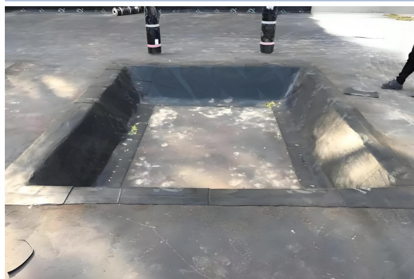
地下室防水施工
