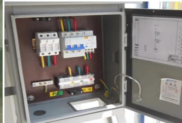
开关箱电器配置示意图
