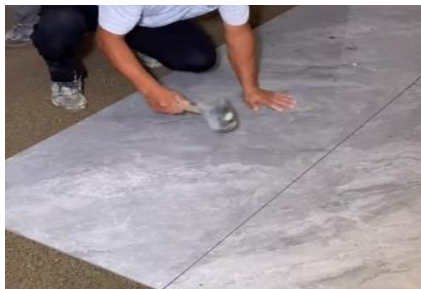
装饰装修施工
