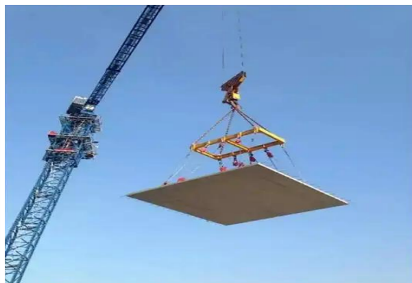
装配式PC叠合板吊装
