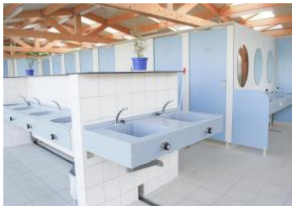
生活区盥洗室
