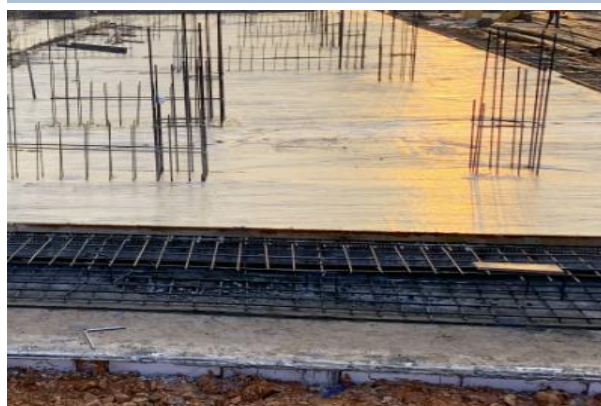
底板混凝土浇筑
