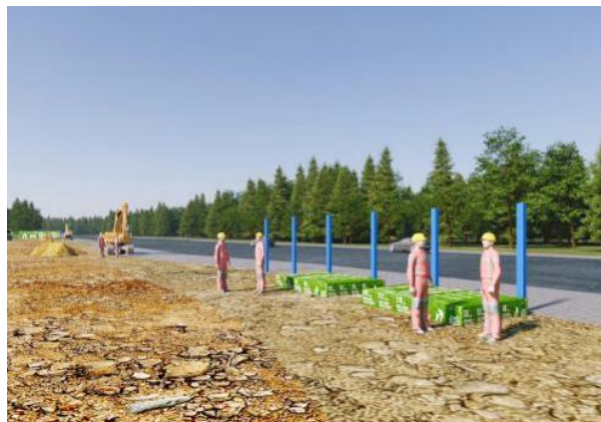
临时围墙建设
