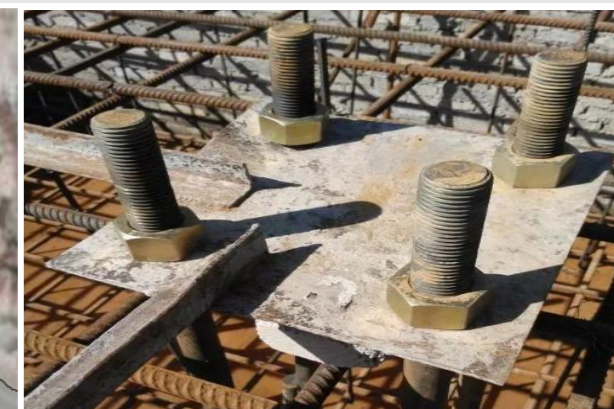
塔吊基础施工
