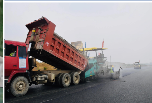
沥青路面摊铺
