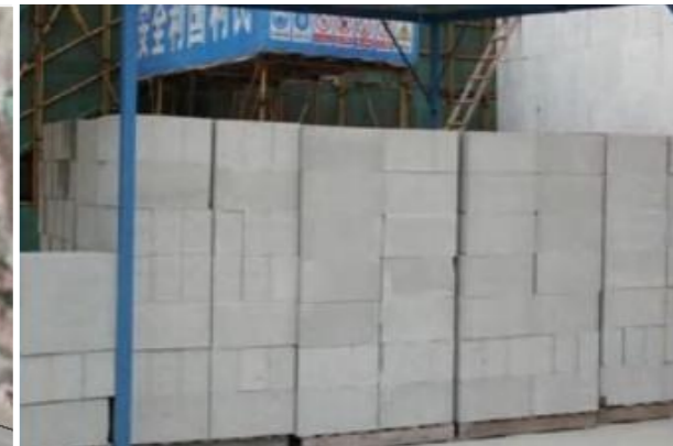
砌体材料堆场
