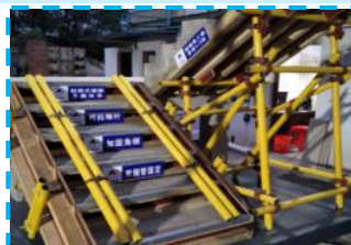
楼梯支模样板
