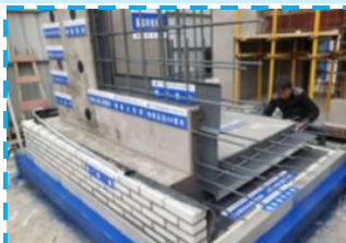
砌体工程样板
