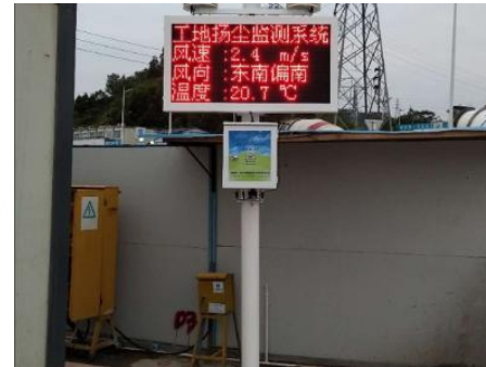
扬尘噪音监测
