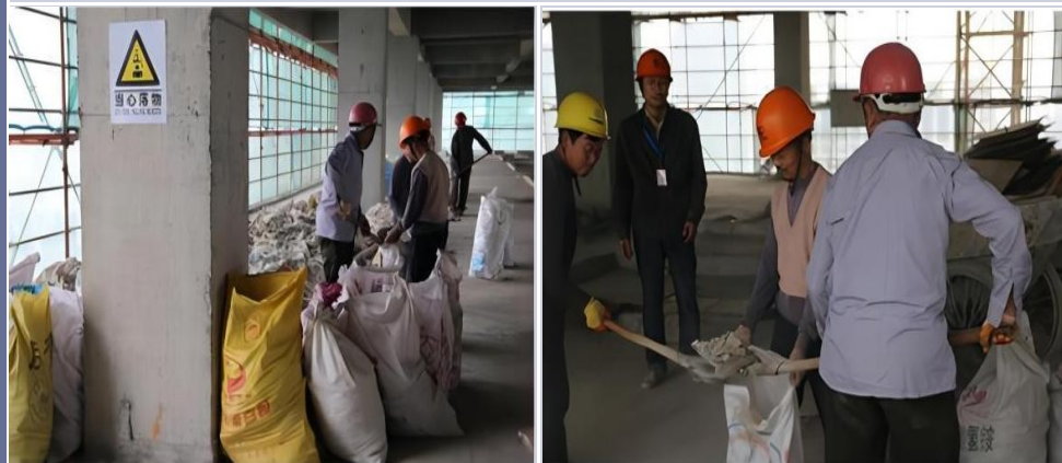
建筑垃圾清理
