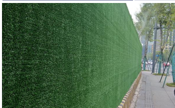
施工工地周边100%围挡
