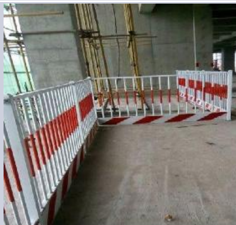
料台临边防护
