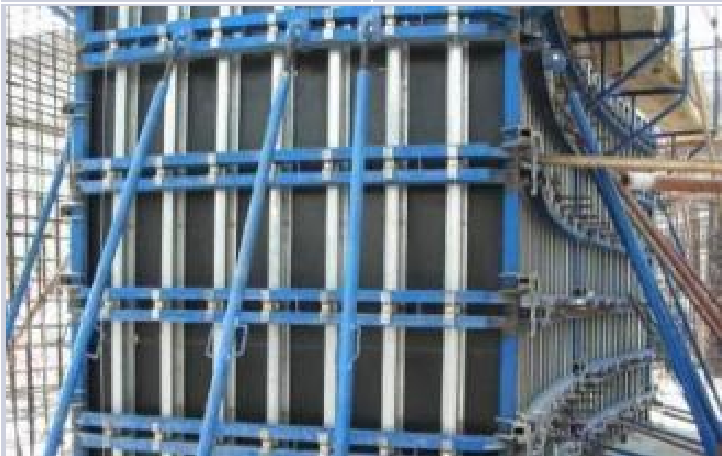
清水混凝土模板示意图
