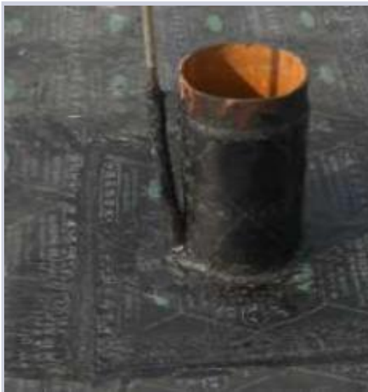
穿换板管道防水处理示意图
