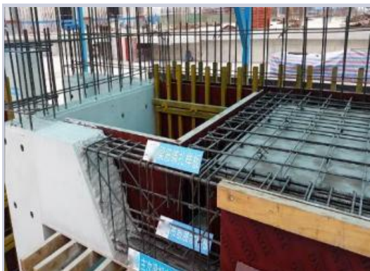
钢筋安装样板展示示意图
