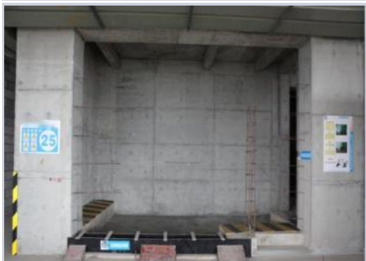
卫生间反坎及砌体拉结筋样板展示示意图
