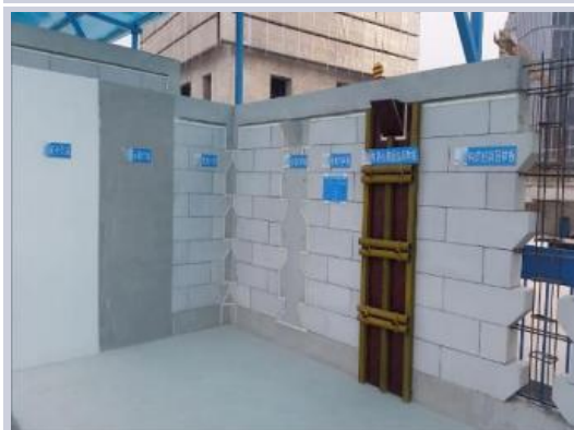
抹灰工程样板展示示意图
