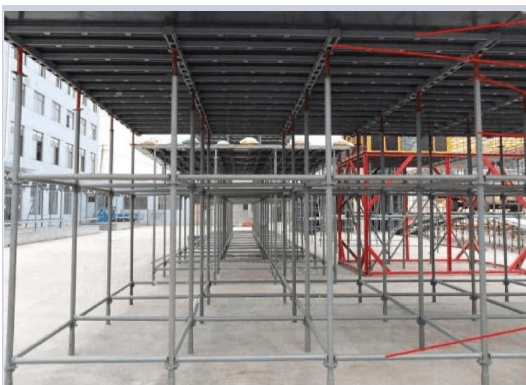
模板安装及支撑体系展示示意图
