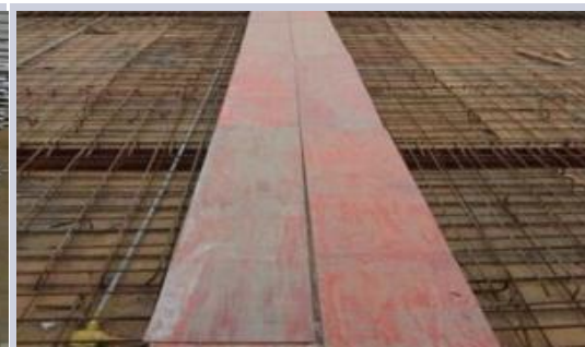
梁板钢筋绑扎示意图
