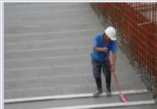
混凝土收毛示意图
