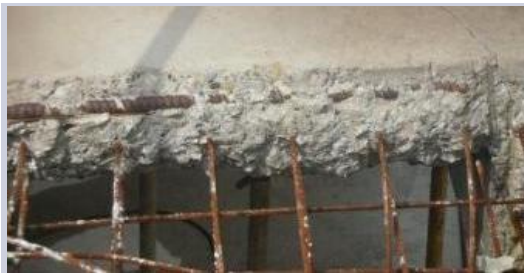
负筋保护层过厚, 板面开裂示意图
