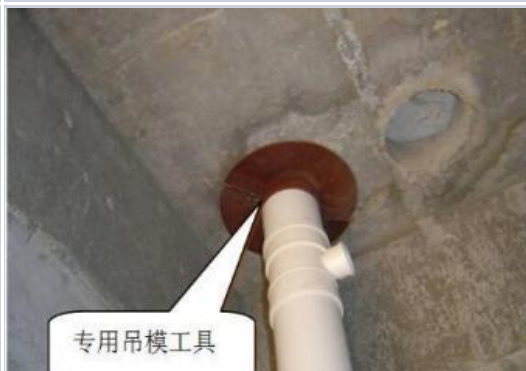
使用专用吊模工具示意图
