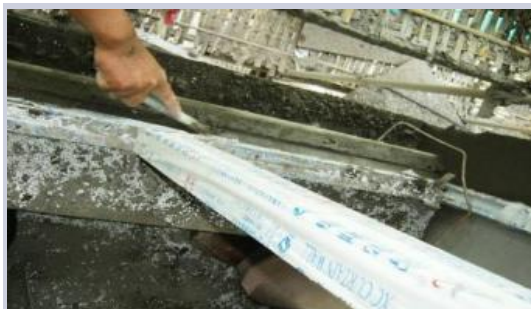
超过3cm必须用c20细石砼进行塞缝示意图
