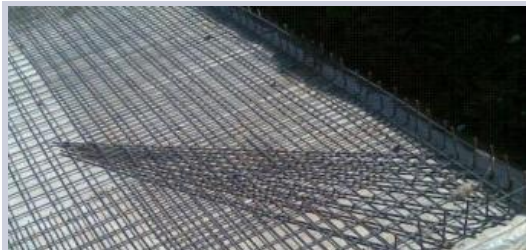
板角放射筋布置示意图
