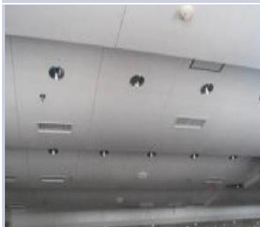
灯具、检修口、喷淋等成排成线示意图
