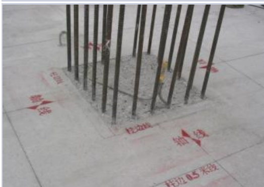
模板弹线定位，误差控制在1mm以内示意图
