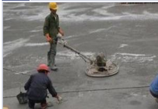
混凝土压光示意图
