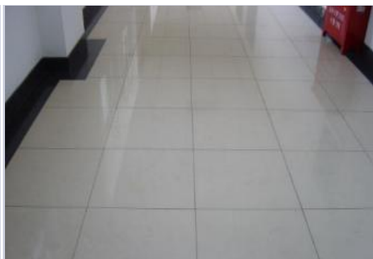
材质均匀、换缝横平竖直示意图
