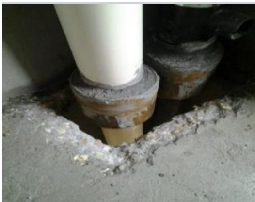
凿毛凿成倒八字示意图
