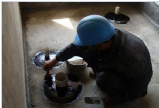
管道防水细部构造示意图
