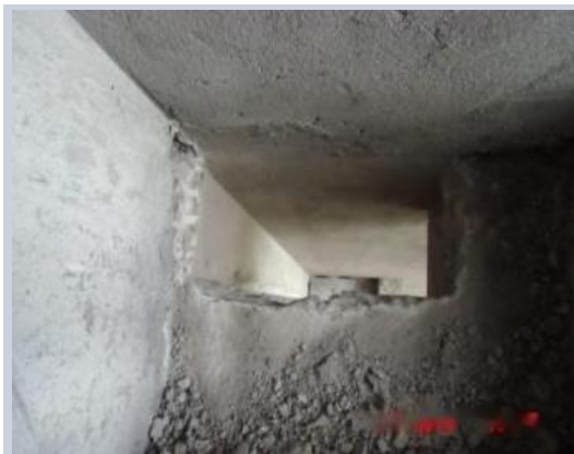
凿毛凿成倒八字示意图
