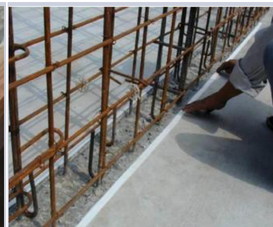
墙柱根部加设海绵条，防止漏浆、烂根示意图
