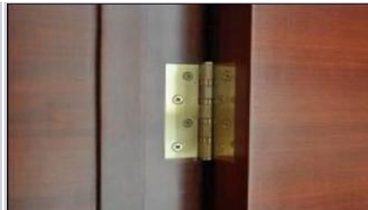
刻槽准确、五金安装规范示意图
