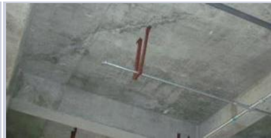
板面开裂渗水示意图
