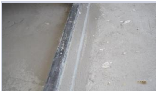
塞缝必须饱满密实，无空鼓现象、并养护7天，严禁施打发泡胶(有孔隙)示意图
