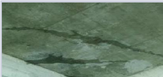
板角裂缝渗漏示意图
