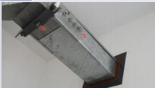
桥架穿墙防火封堵示意图
