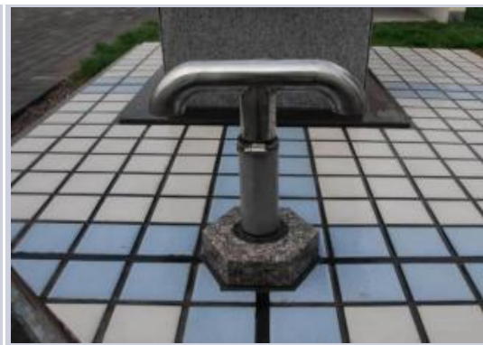
屋面排气管示意图
