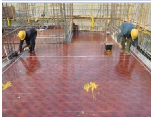
绑扎前弹定位线示意图
