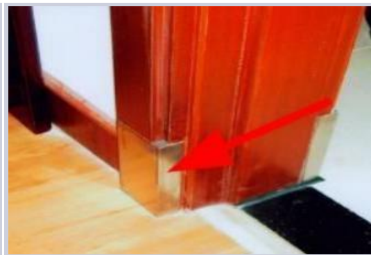
门套金属包脚防止受潮腐烂示意图
