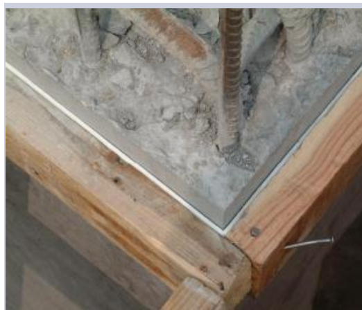
墙柱根部加设海绵条，防止漏浆、烂根示意图
