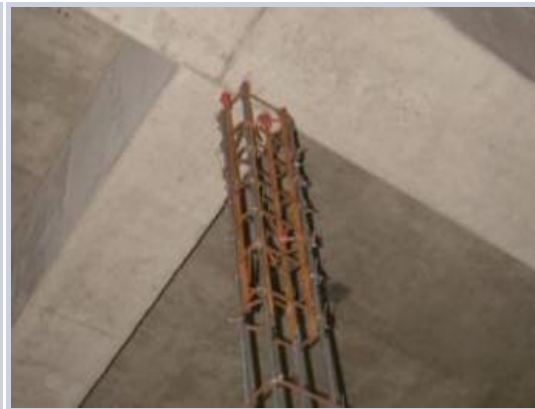
构造柱设置示意图
