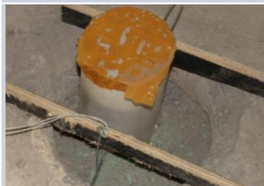
吊洞严禁铁丝贯穿拉结示意图
