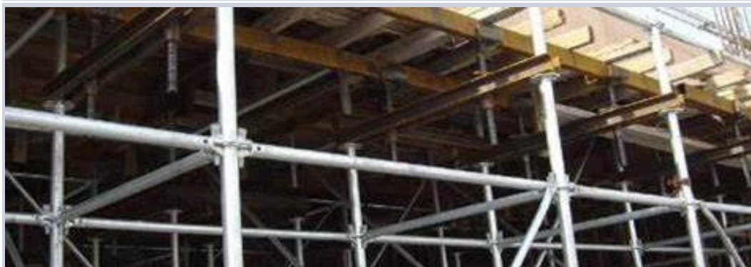
梁底模板、模板支撑搭设示意图
