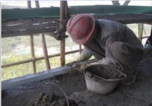
用1: 2.5: 0.8干燥砂浆塞缝示意图
