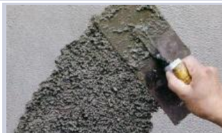
FTC节能材料分层涂抹
