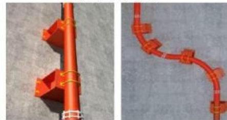
竖向管道固定
