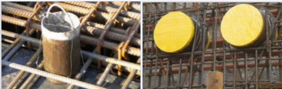
套管加筋固定示意图
