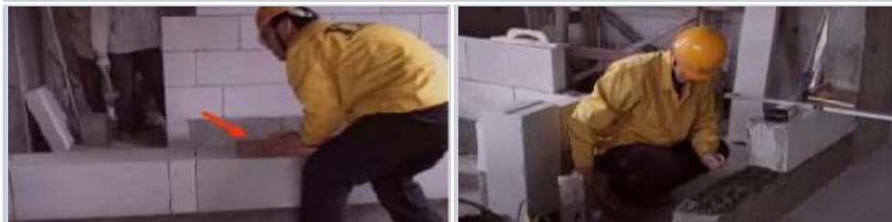
砌筑第一皮砌块示意图
