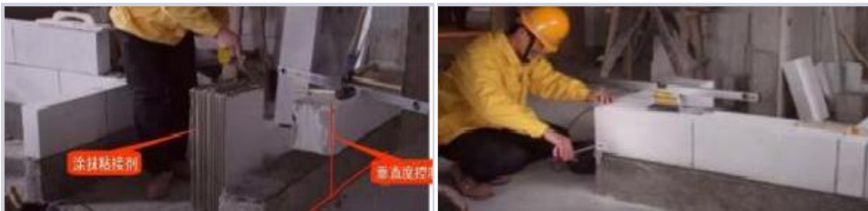
水平和垂直度控制示意图
