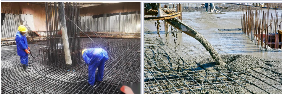
基础底板浇筑示意图
