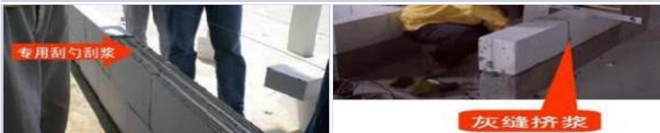
灰缝控制示意图
