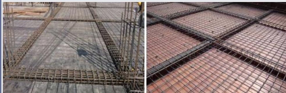
梁、板钢筋安装示意图
