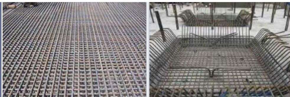
底板钢筋安装示意图
