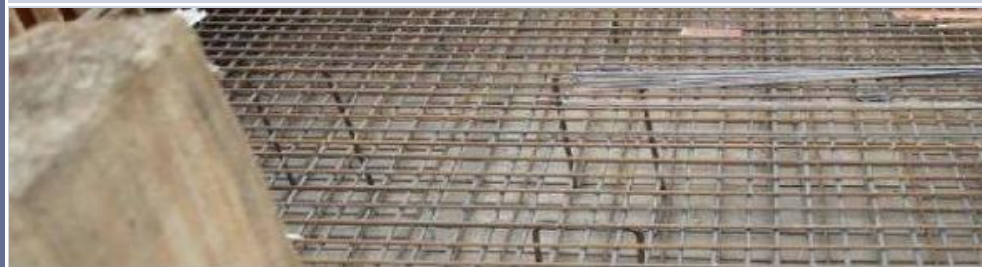
底板及承台钢筋支架示意图
