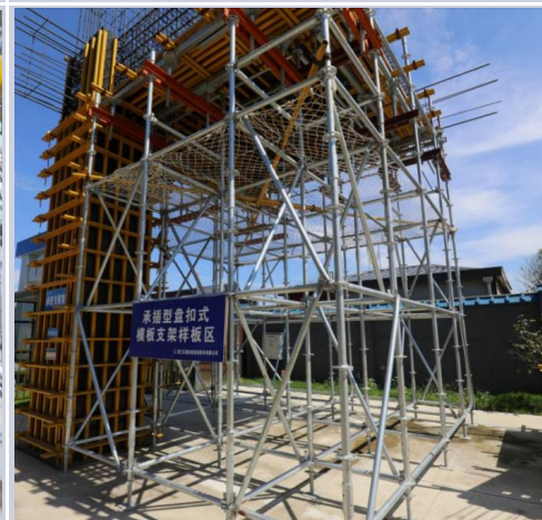
方柱模板支设示意图
