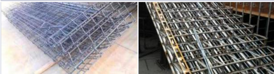
楼梯钢筋安装示意图
