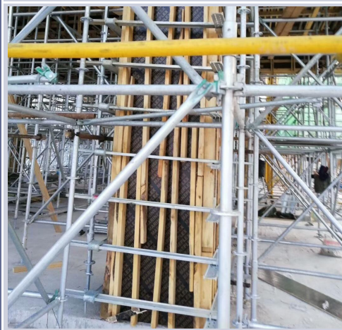
方柱模板支设示意图
