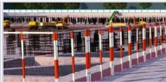
分层开挖至基坑底部基坑临边防护
