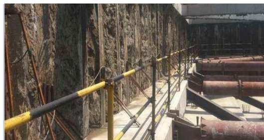
钻孔灌注桩围护
