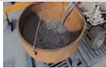
9、浇灌水下混凝土
