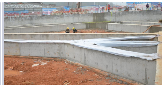
挖至支撑底进行支撑
