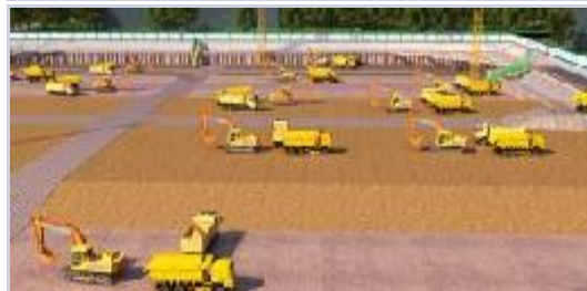
分层、分段开挖至基坑底部
