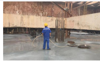
混凝土浇水养护
