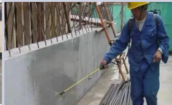
混凝土浇水养护
