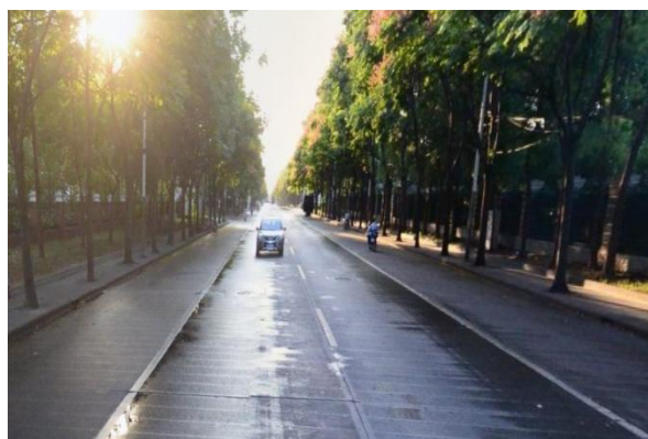
项目南侧的绥德路
