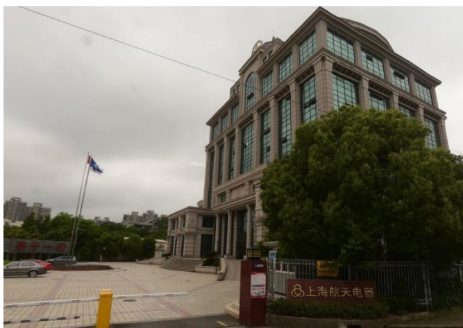
本项目所在建筑
