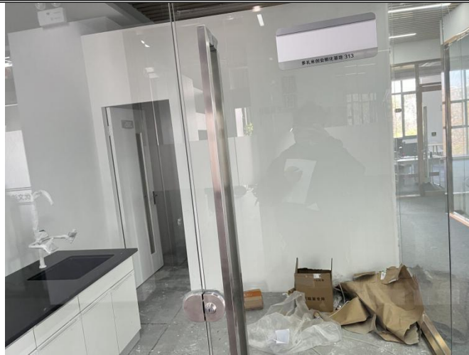
项目所在房间（313室）
