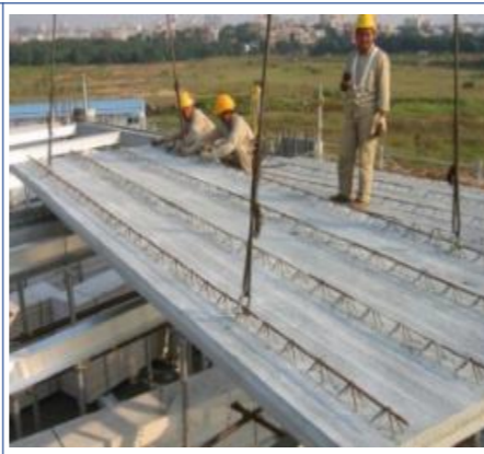
吊装作业安排专人指挥
