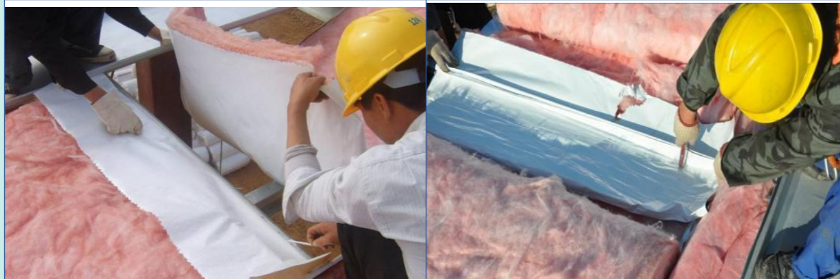
保温棉横向粘接在屋面檩条上
