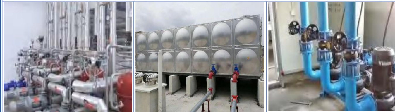
给水设备安装
