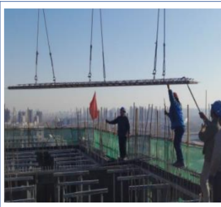
预制构件吊装应系好牵引绳
