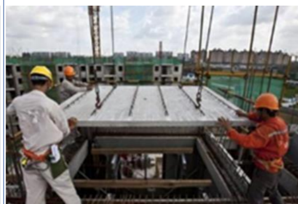
叠合楼板安装
