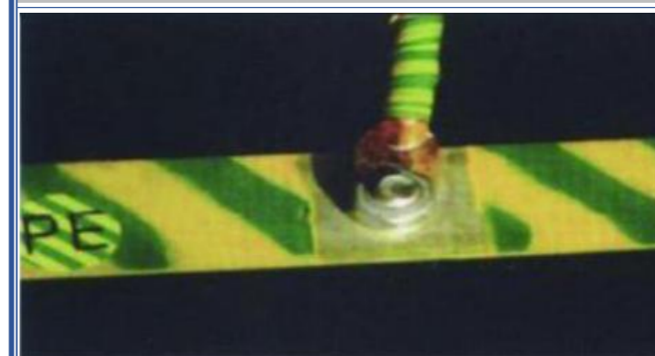
与电气设备的金属外壳连接的保护零线，应接在电闸的接零端子上
