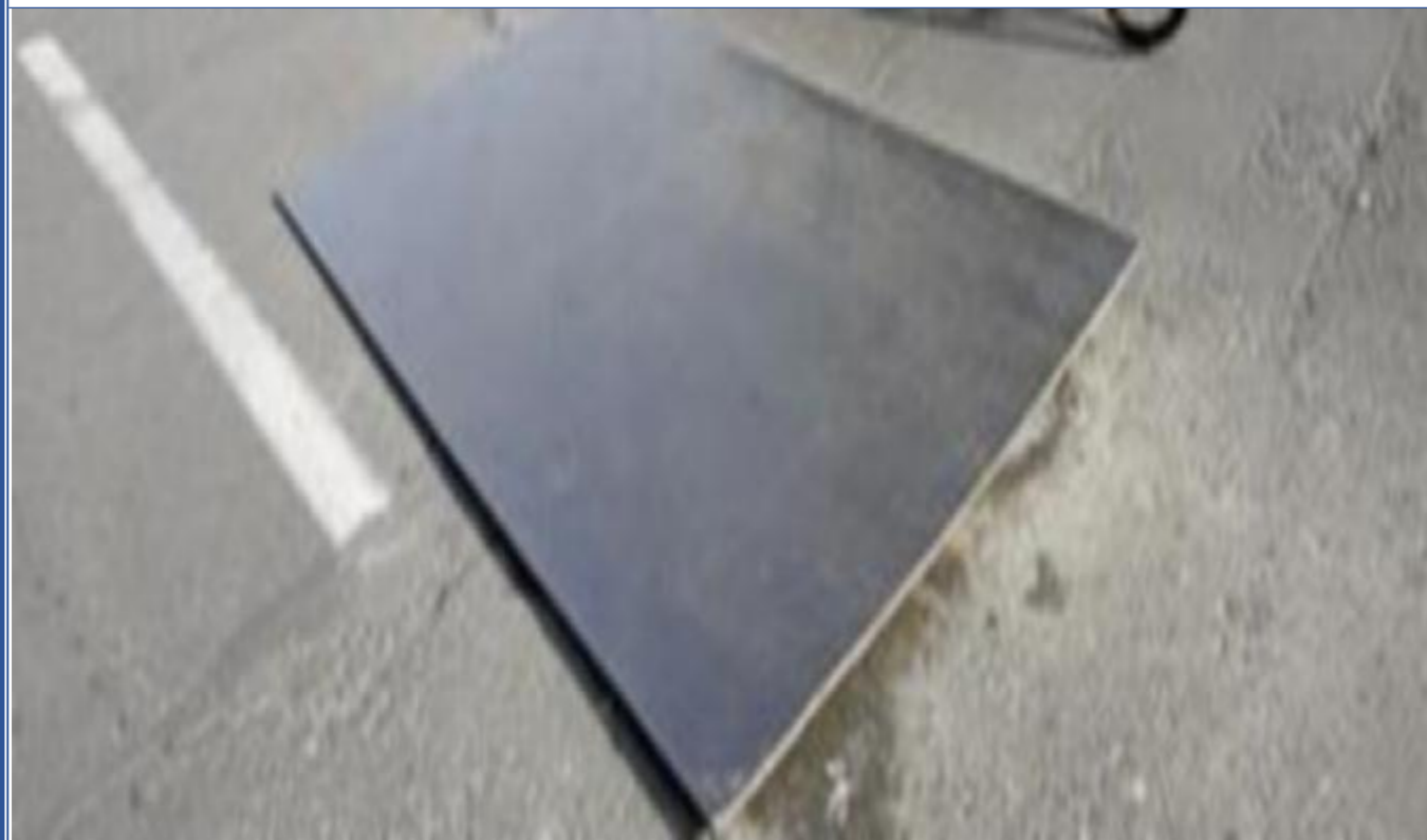
行车道路井盖临时覆盖
