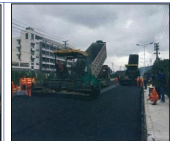
摊铺机成梯队作业
