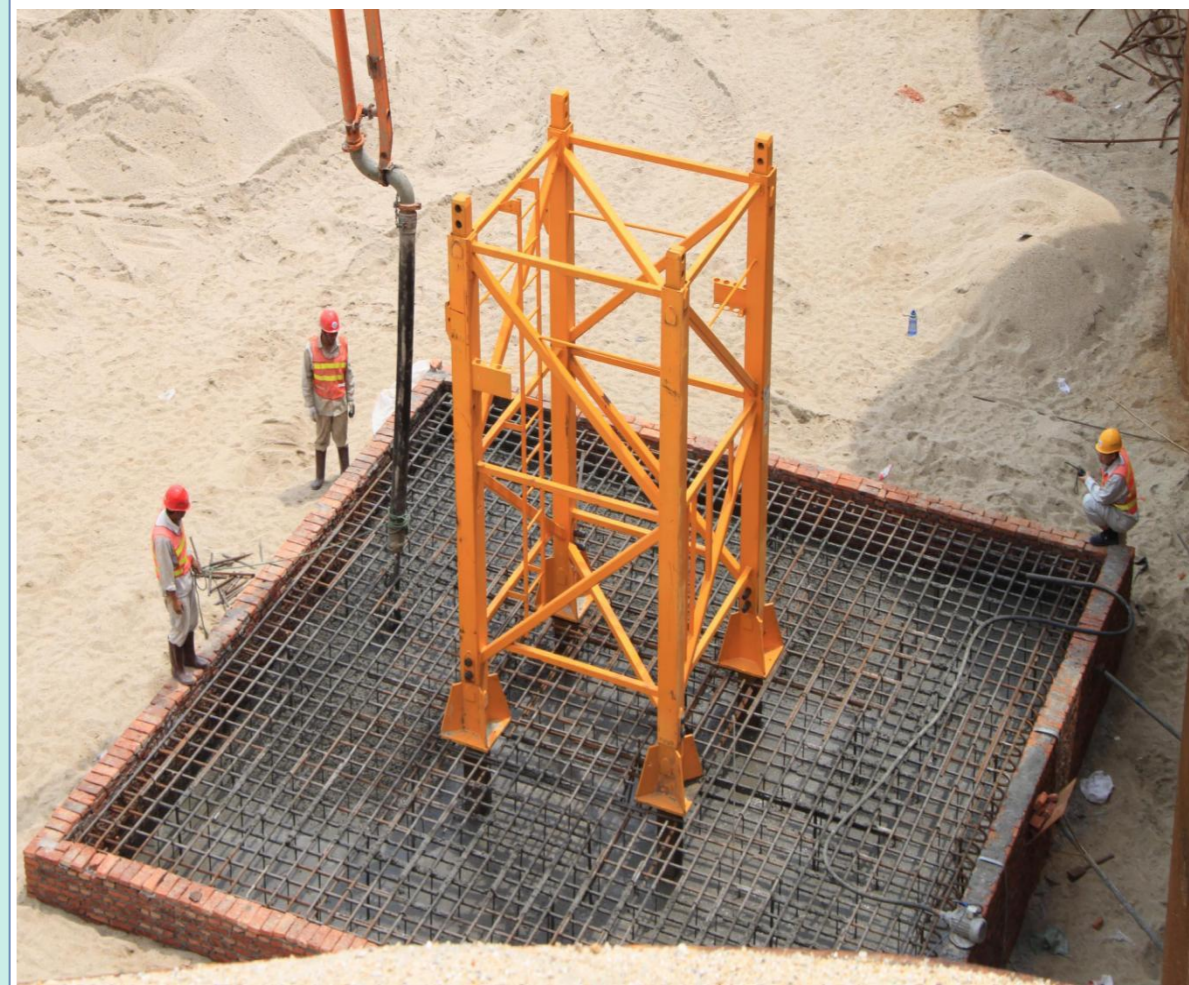
塔吊基础设计形式
