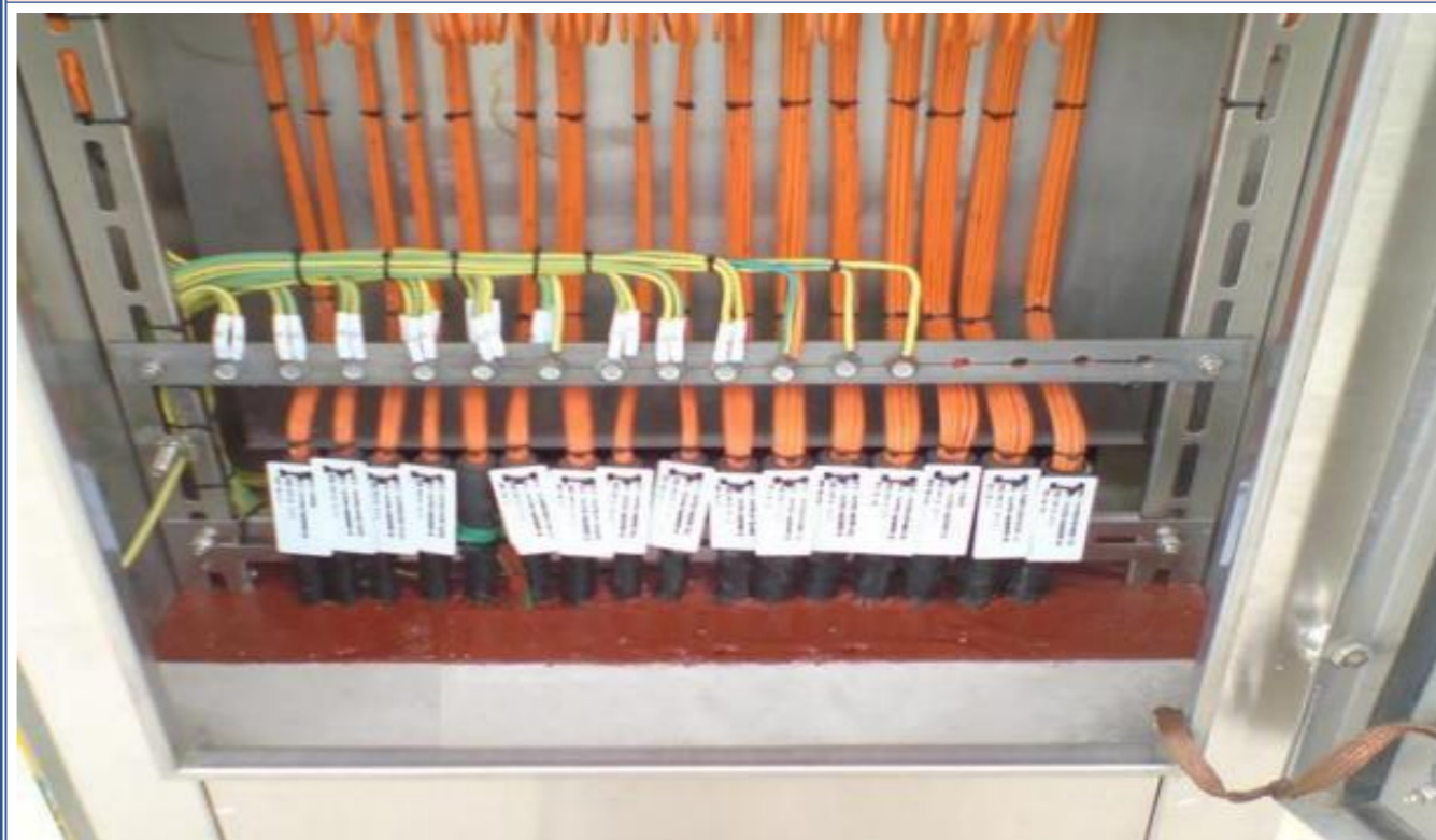
接线端子箱防火封堵实例
