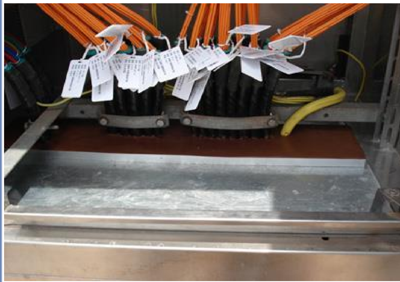
接线端子箱防火封堵实例
