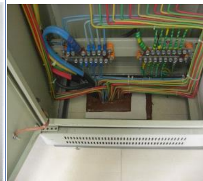
配电盘、柜防火封堵实例
