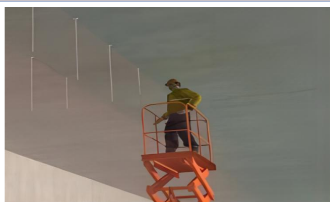
水平风管安装示意图
