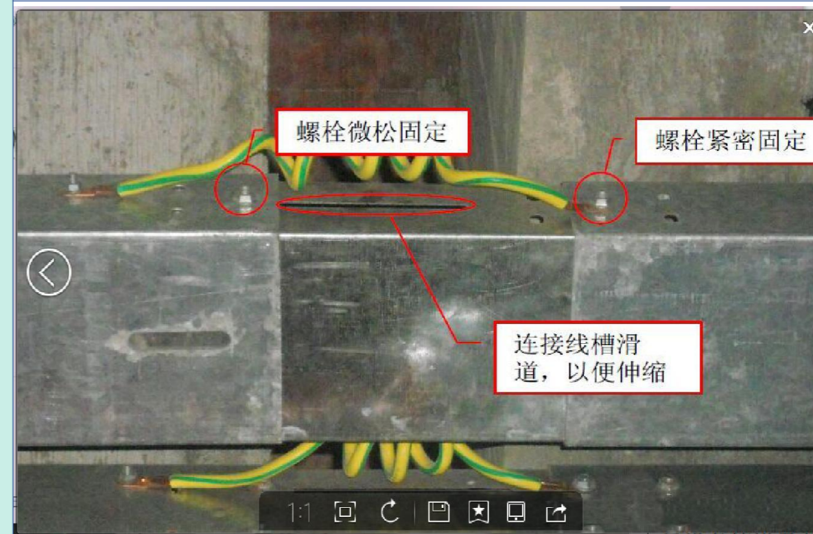
桥架伸缩连接示意图
