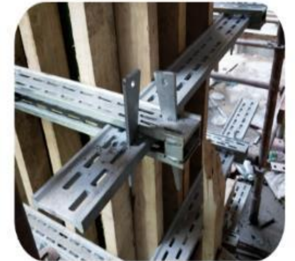
剪力墙支撑夹具体系
