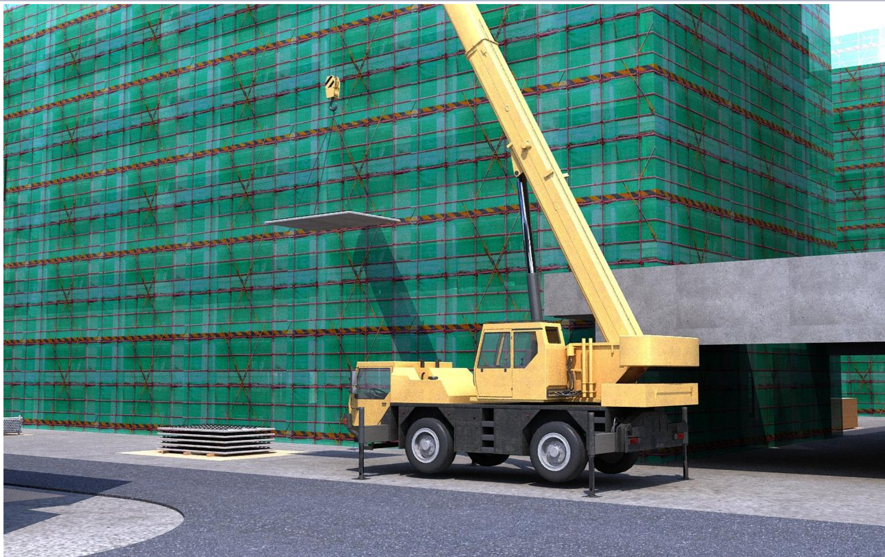
装配式吊吊装
