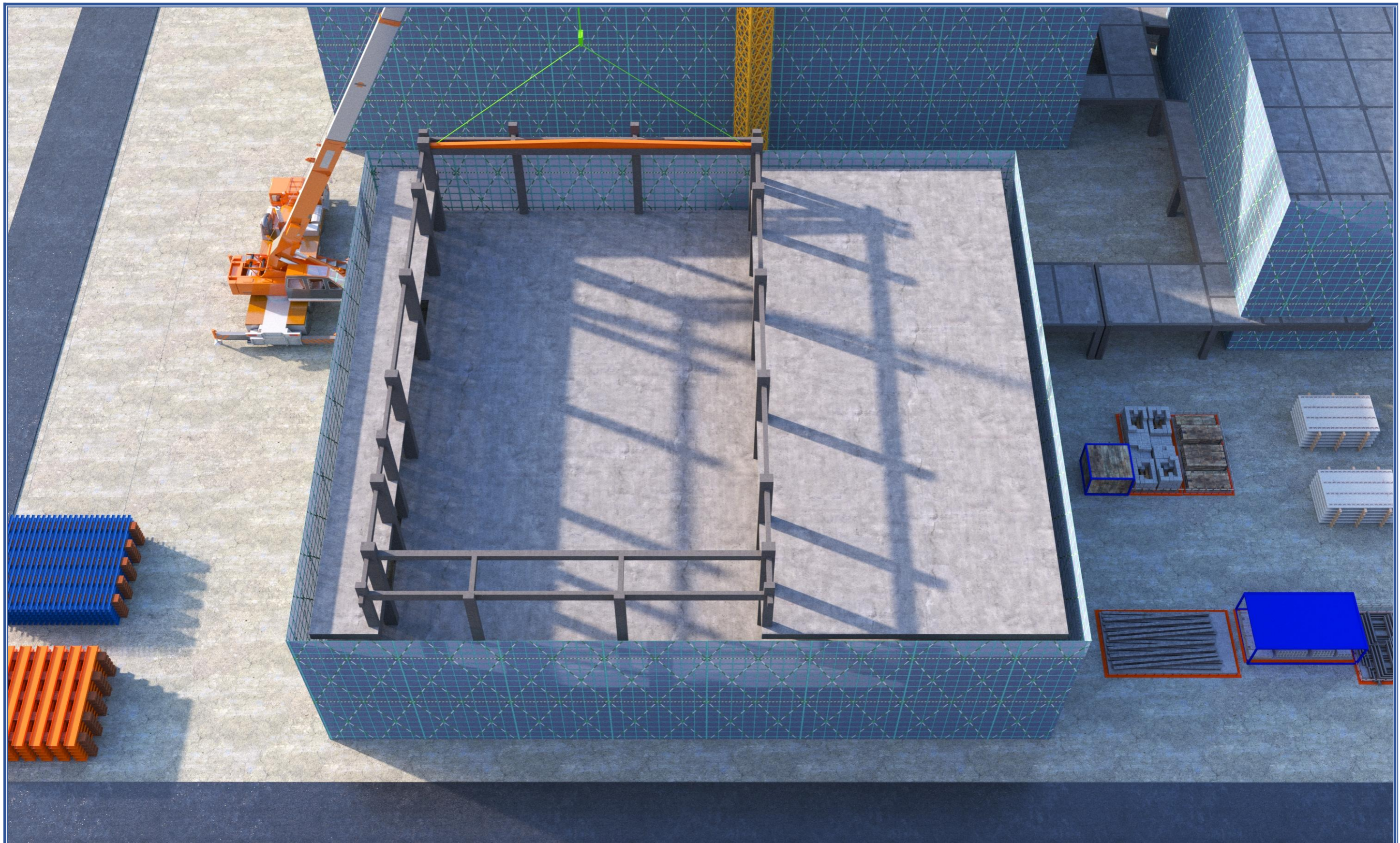
A 轴钢梁吊装
