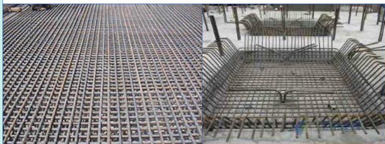
底板钢筋安装示
