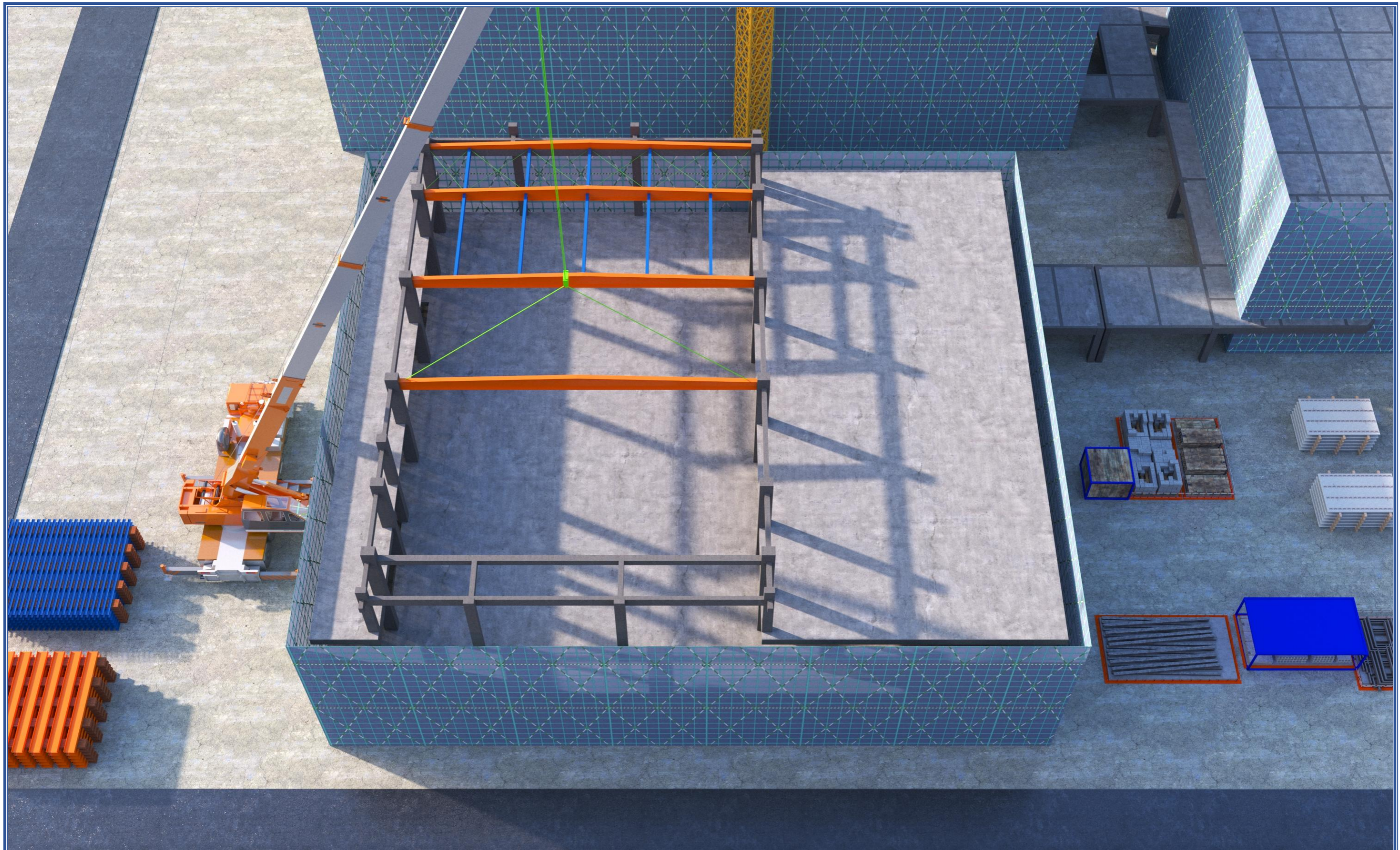
D 轴钢梁吊装, B-C 轴屋面结构施工
