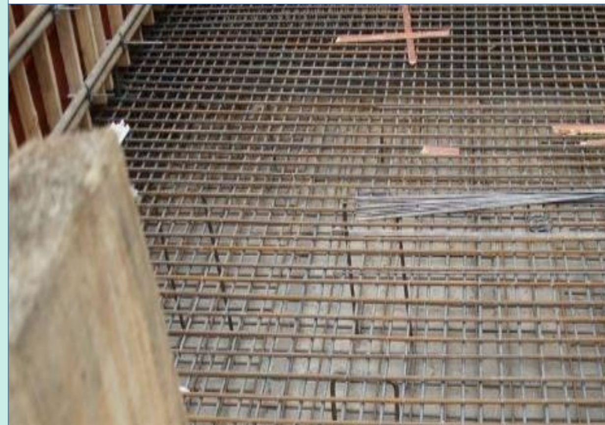
底板及承台钢筋支架示意图
