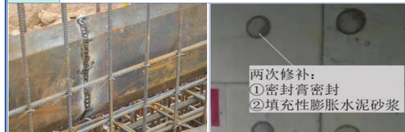
止水钢板安装质量控制
