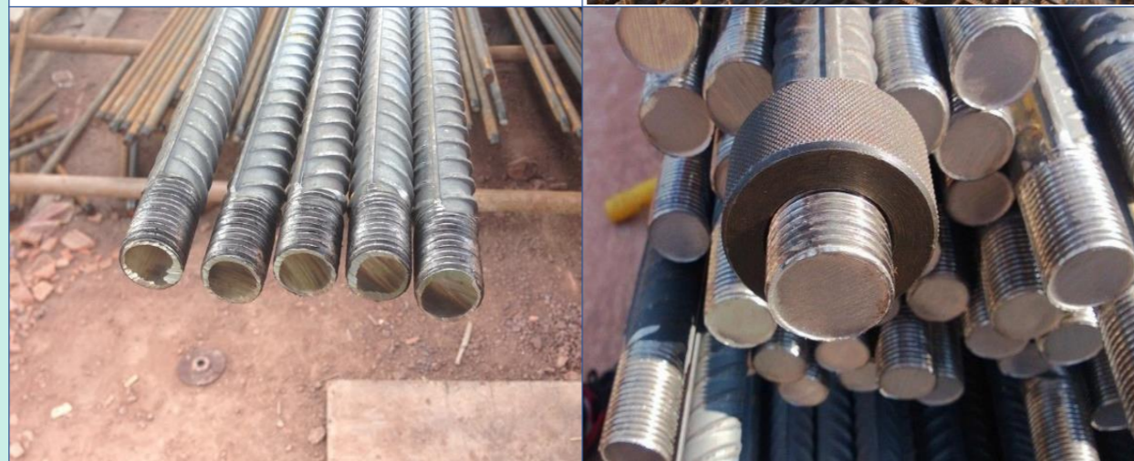
套筒连接示意
