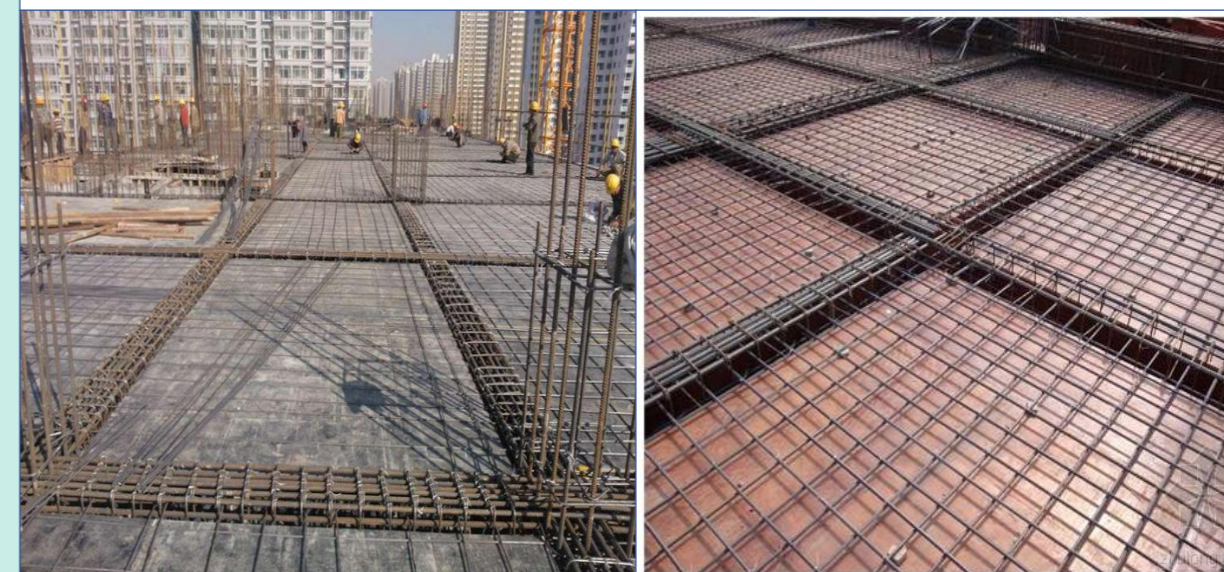
梁、板钢筋绑扎示意图
