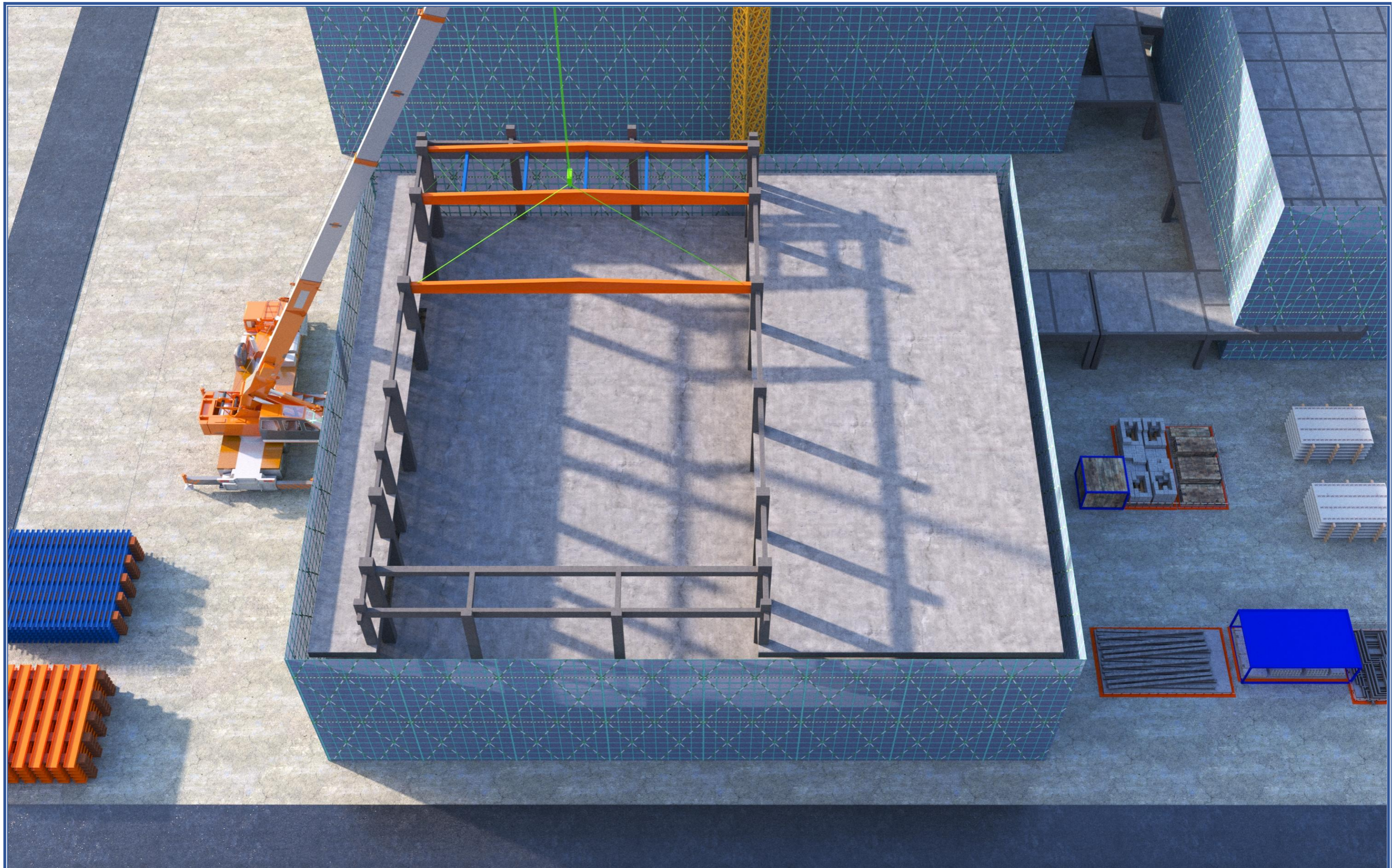
C 轴钢梁吊装
