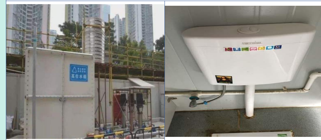
(6) 施工区水循环利用
