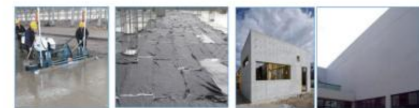
原浆一次找平 洒水养护 清水混凝土
