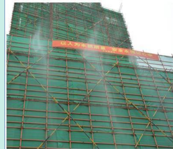
塔吊及脚手架喷雾系统
