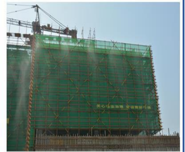
塔吊及脚手架喷雾系统
