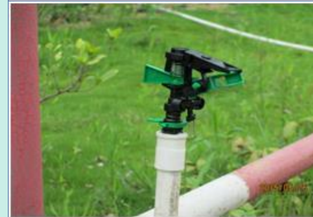
施工现场安装自动喷雾系统
