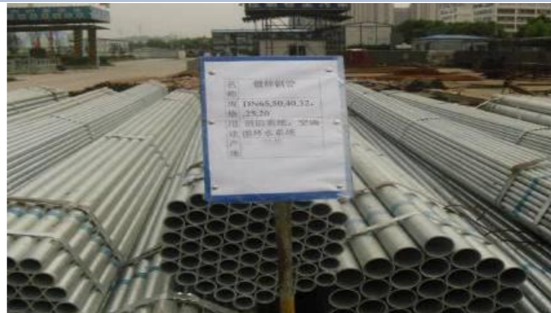
图：水电材料堆场
