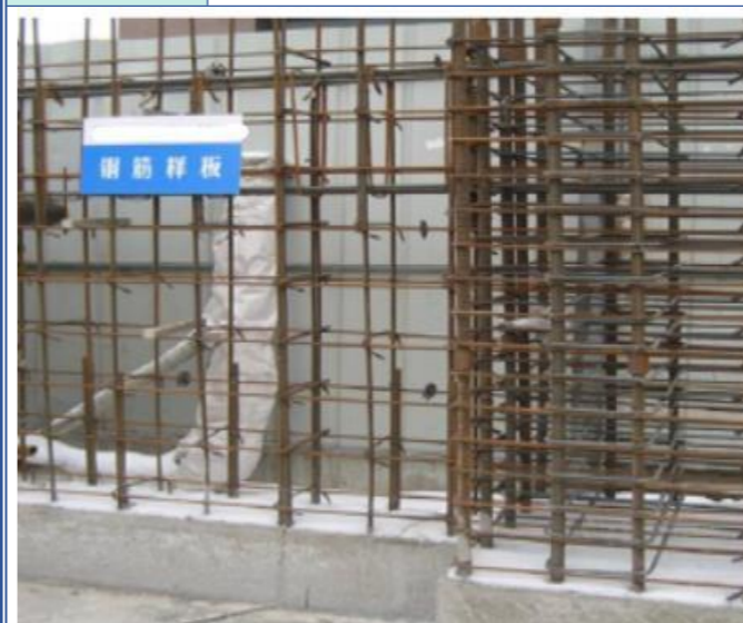
钢筋样板展示
