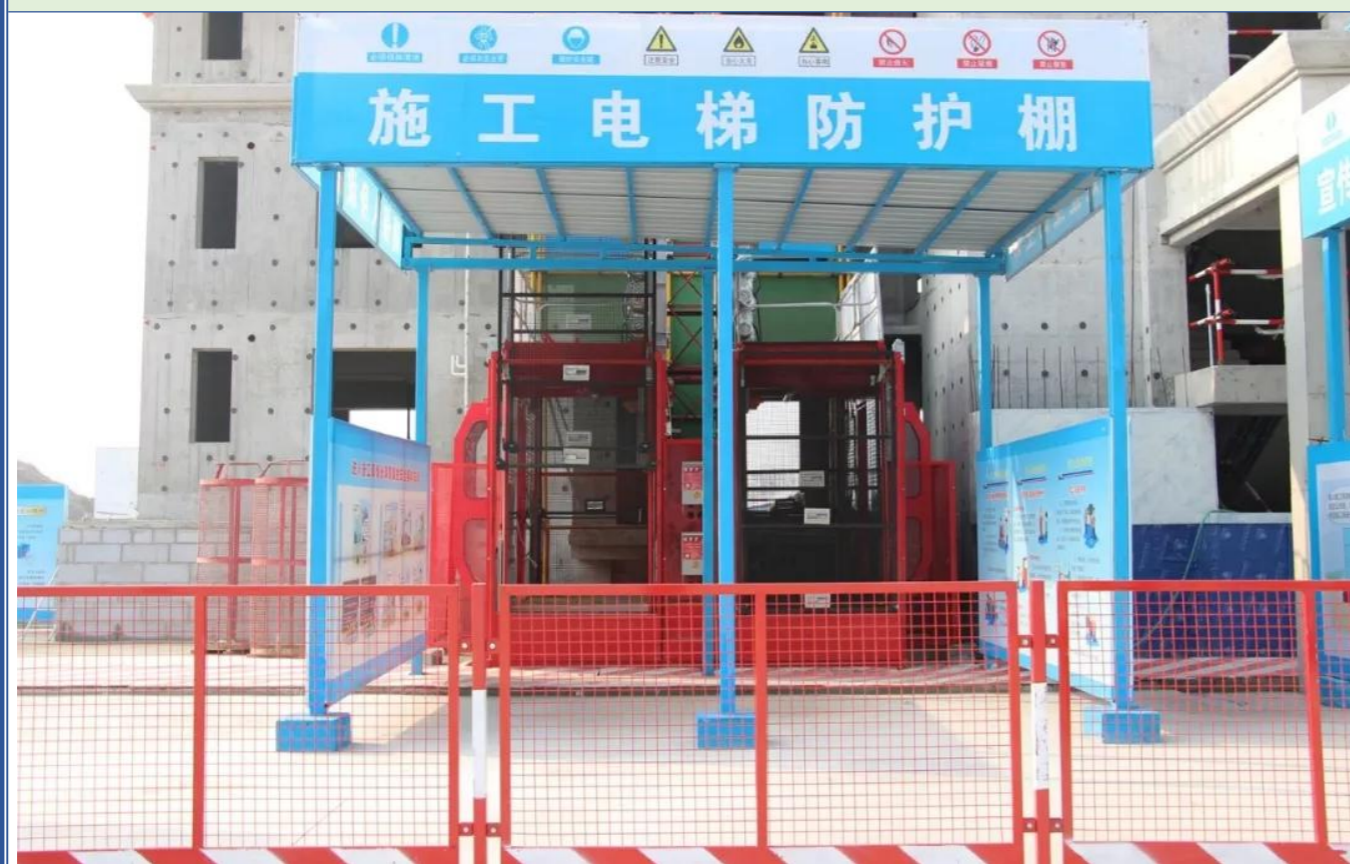
施工电梯防护棚
