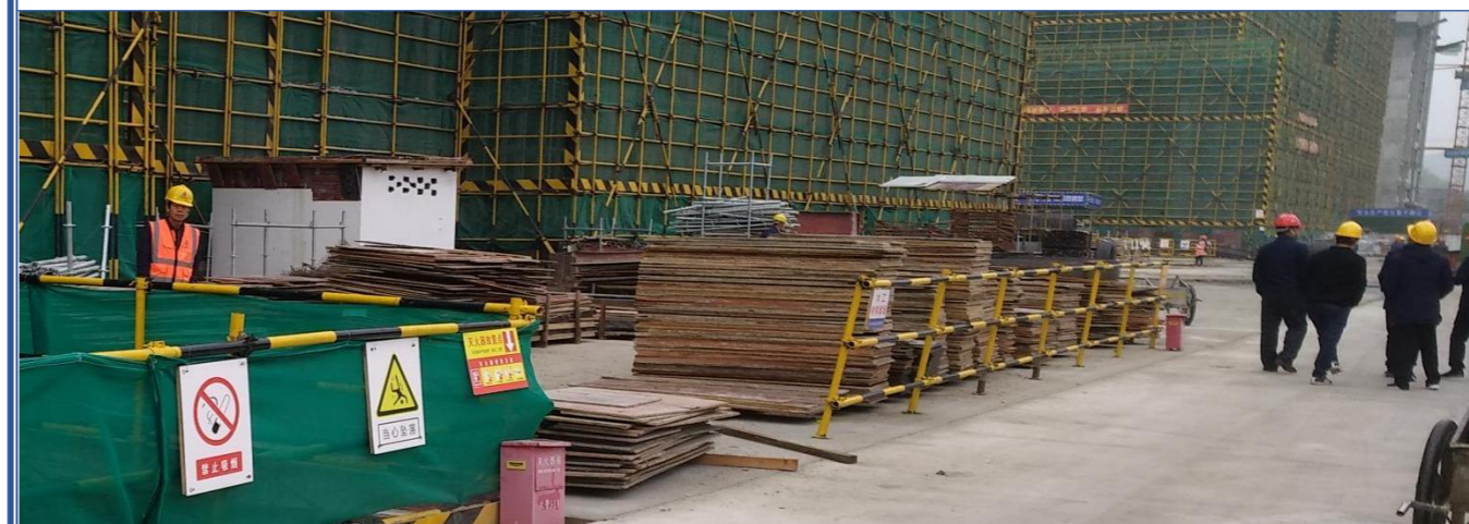
图：模板方木堆场
