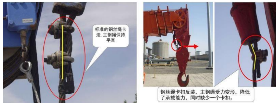
6、钢丝绳连接卸扣应朝向长绳（主受力绳）。
