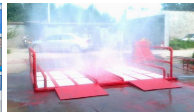
洗车池及沉淀池
