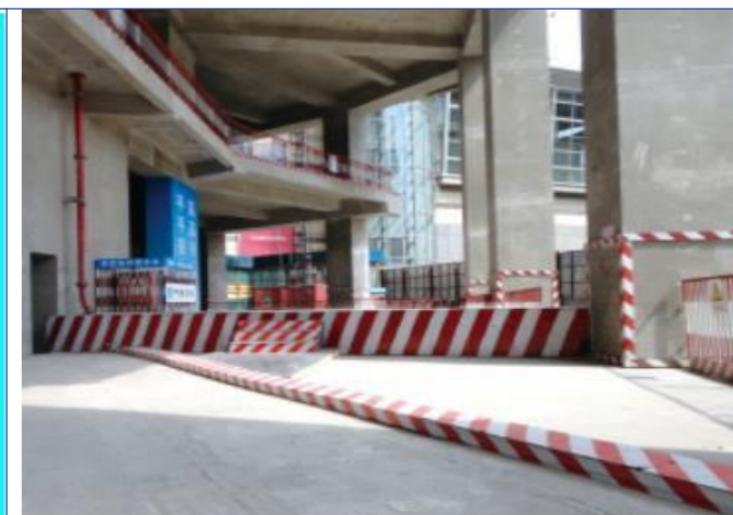
电缆敷设防护
