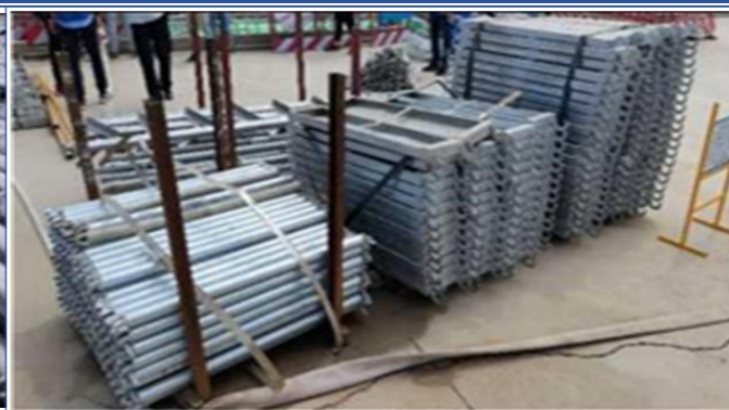
4. 外架安全通道防护棚
