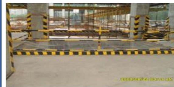
预留洞口防护应用示意（主体结构施工阶段）
