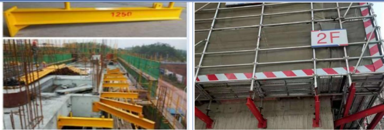
12. 脚手架与结构间隔离措施
