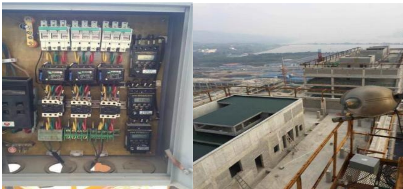
大灯采用限时器定时开关大灯照射范围为施工区
