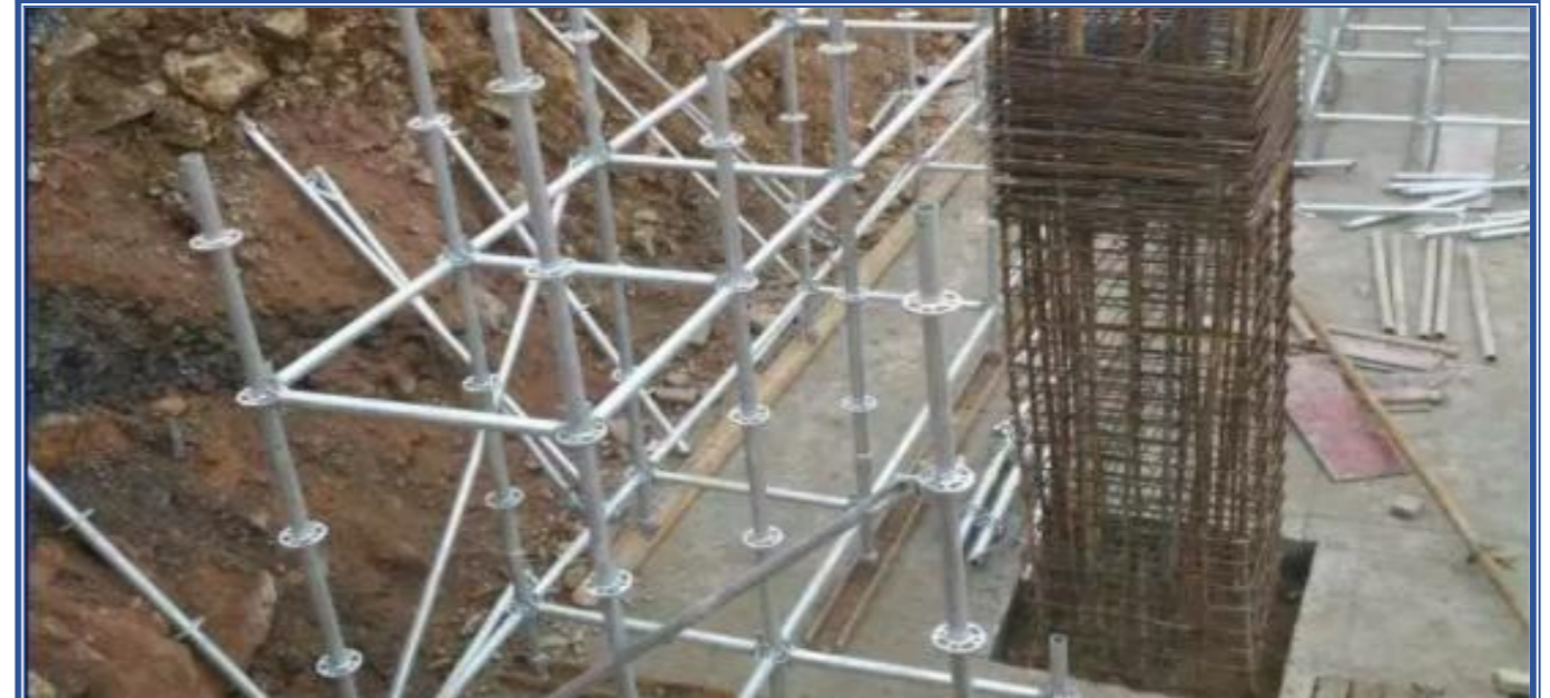
7. 外脚手架上人通道
