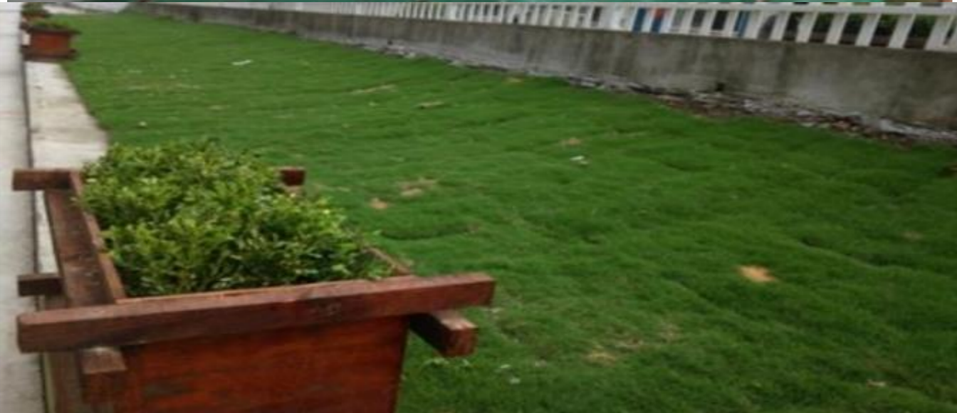
裸土覆盖现场绿化
