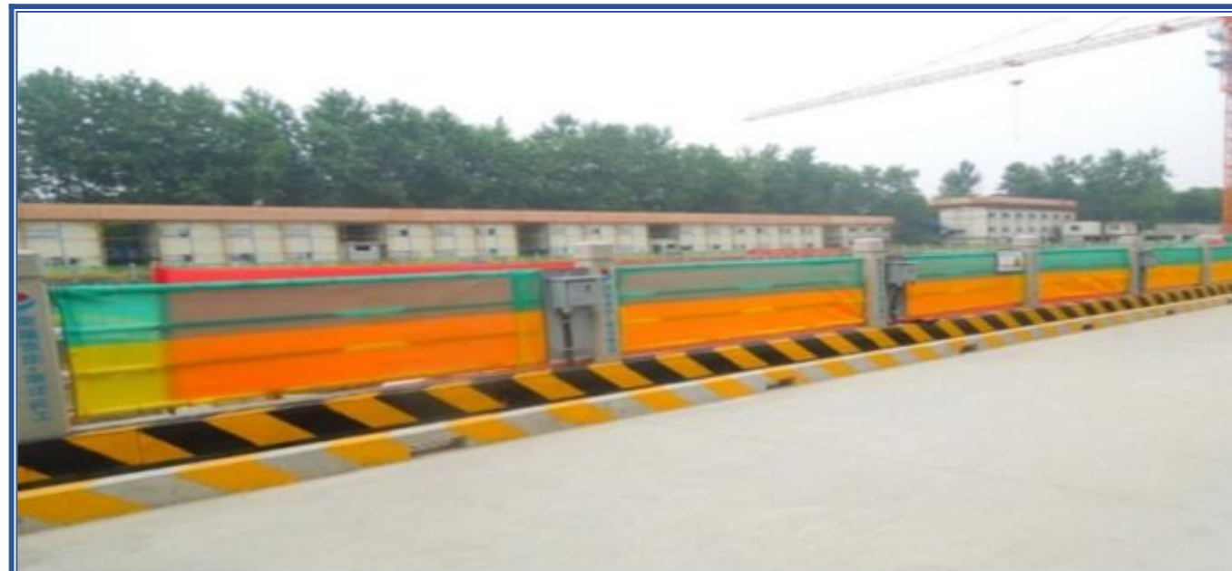
现场道路硬化
