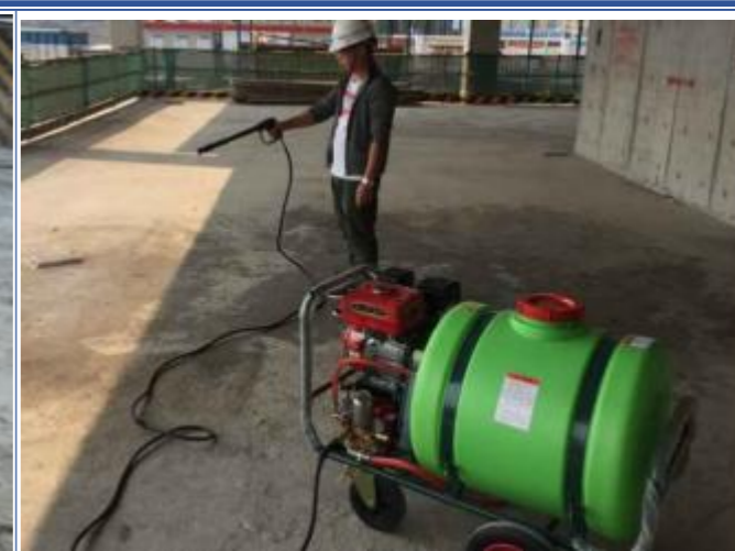
移动喷淋装置洒水降尘
