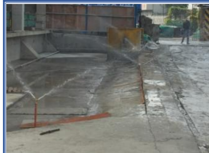
固定喷淋装置定时洒水降尘
