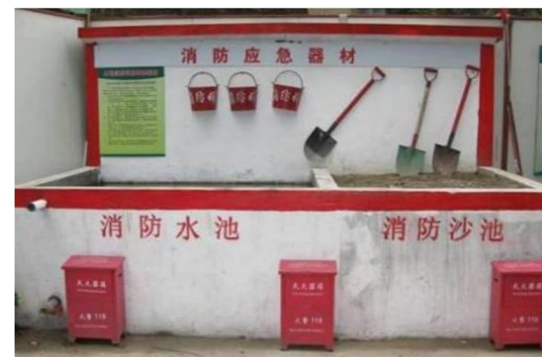
图：消防水池及消防沙池
