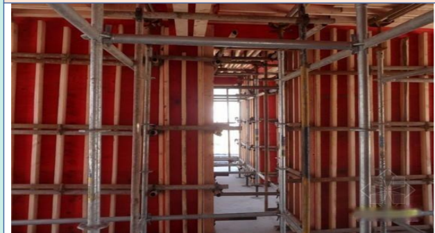
(6) 墙柱模板支撑
