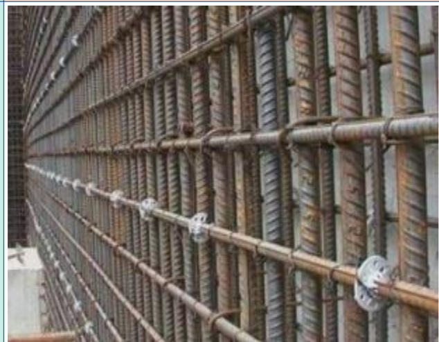
墙、柱钢筋保护层垫块：墙、柱采用成品塑料垫块。设置要求：墙柱纵横间距 \leq 600\text{mm} ，柱沿柱角布置，每 \leq 600\text{mm} 设置一个。
