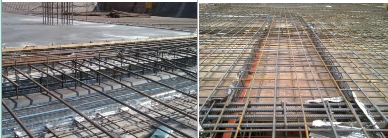
后浇带模板：后浇带采用快易收口网与钢筋骨架固定
