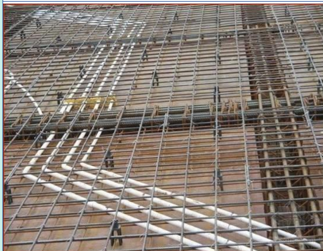
板面筋垫块：采用成品塑料垫块或钢筋 Z 型马凳，布置间距 1000*1000 (梅
