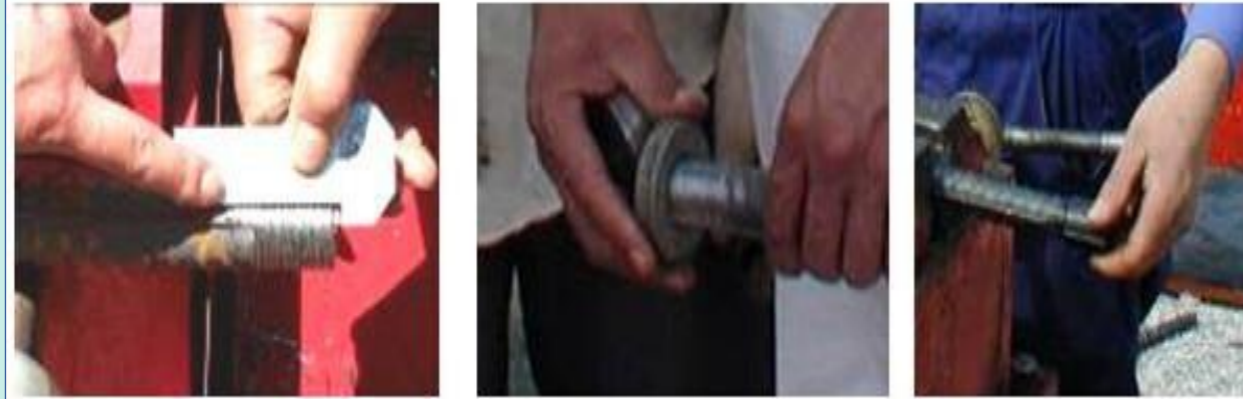
直螺纹丝头采用通、止环规检查质量
