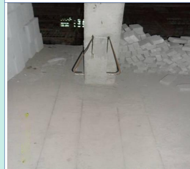
施工放线 1：弹砌筑双控制线。
