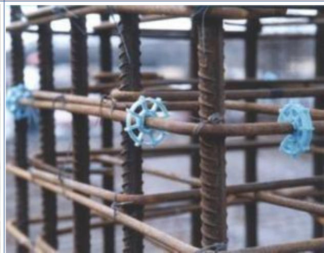
墙、柱钢筋保护层垫块：墙、柱采用成品塑料垫块。设置要求：墙柱纵横间距 \leq 600\text{mm} ，柱沿柱角布置，每 \leq 600\text{mm} 设置一个。
