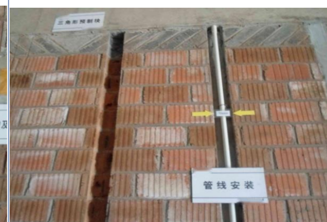
开槽、管线敷设
