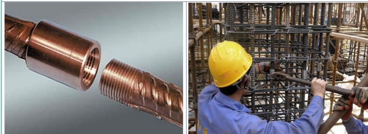
各钢筋套丝的完整牙数：8
