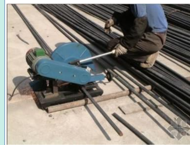
钢筋下料切割
