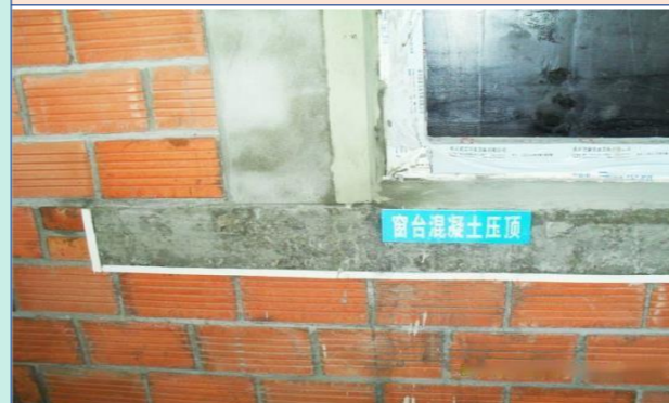
保证窗台压顶入墙长度
