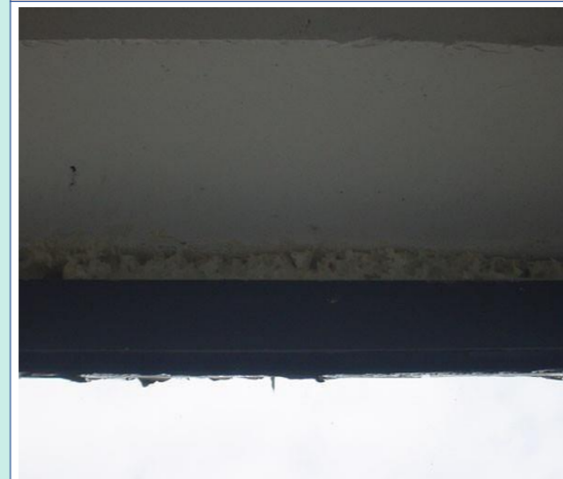
发泡剂用切割方式处理
