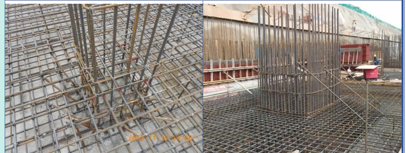
墙柱基础插筋
