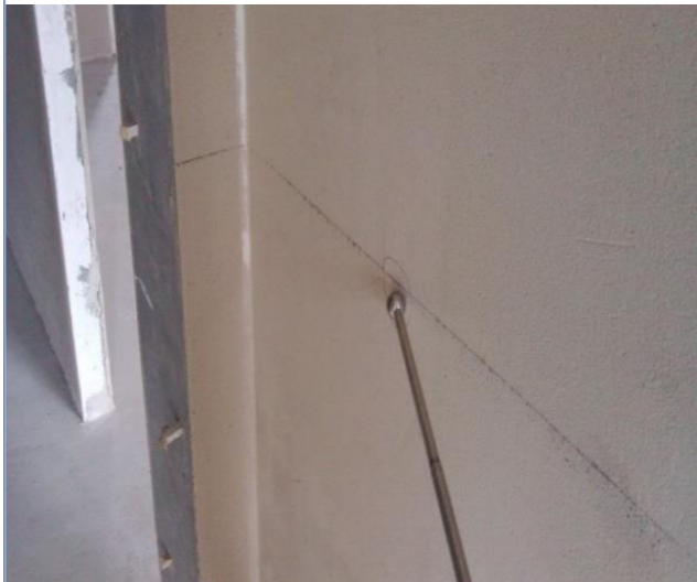
面层抹灰完成
