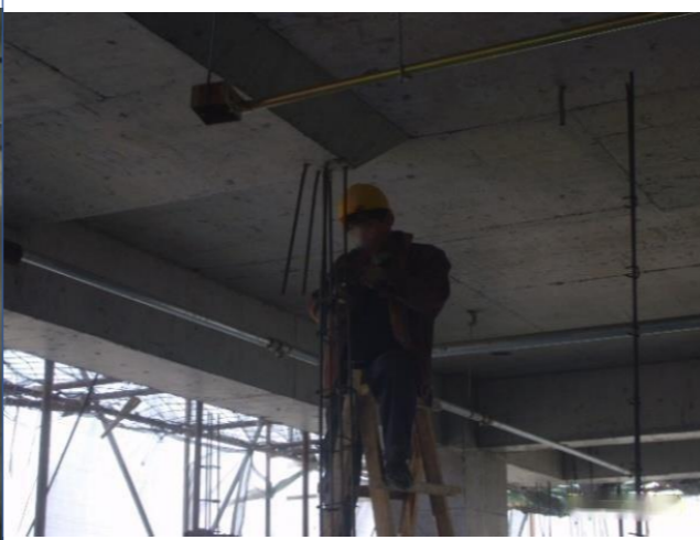
构造柱钢筋绑扎
