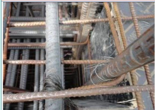
梁柱节点核心区加密箍筋间距大于 100mm
