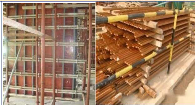
(6) 墙柱模板支撑
