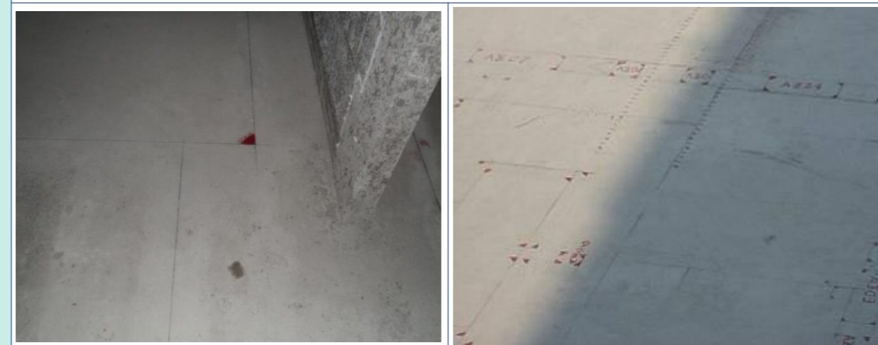
基层清理、施工放线
