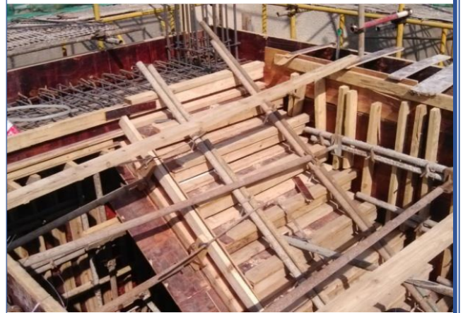
封闭式楼梯模板：推荐楼梯模板采用封闭式或钢板和型钢制作定型楼梯踢面板，有利于成平保护和浇灌密实。
