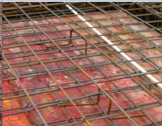
板面筋垫块：采用成品塑料垫块或钢筋 Z 型马凳，布置间距 1000*1000 (梅
