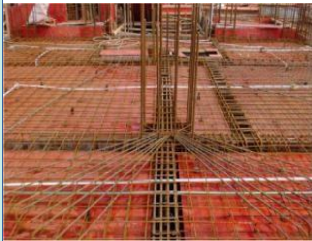
放射钢筋：板内阳角需增加 7 根直径同板面筋的放射钢筋。 洞口预留：预留洞口应按图纸要求设置加强钢筋。
