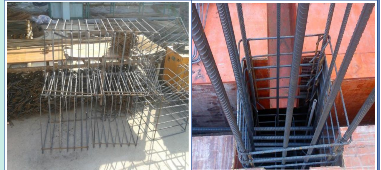
梁柱节点柱箍筋笼制作图
