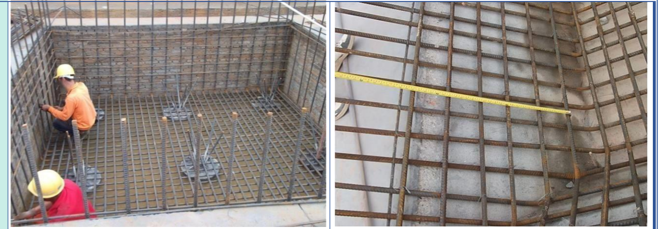
承台钢筋绑扎:承台钢筋位置应正确、横平竖直且应符合规范要求;
