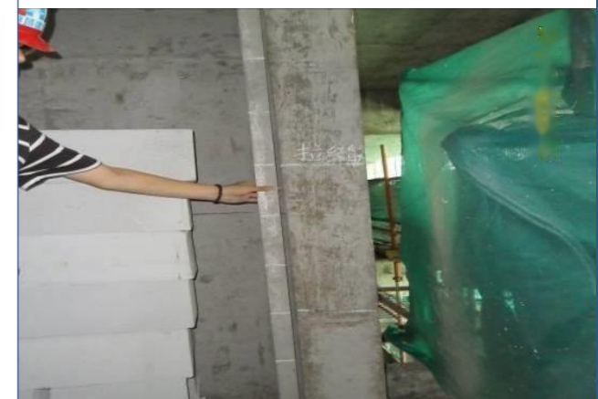
预制 4：预制门窗洞口边预制块。
