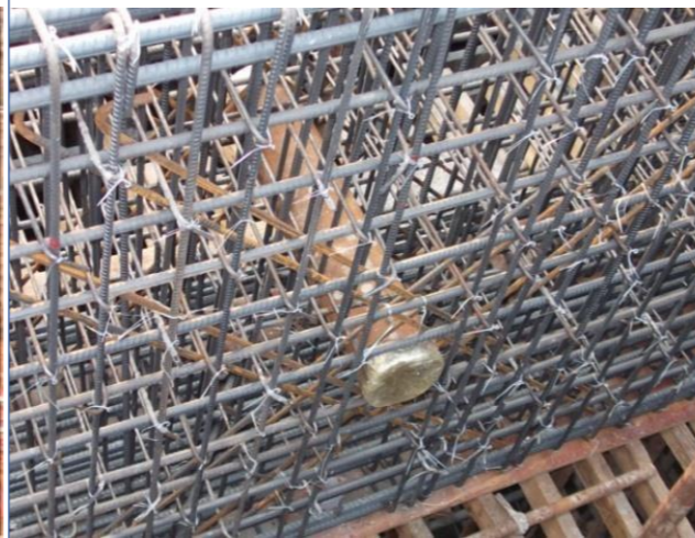
放射钢筋：板内阳角需增加 7 根直径同板面筋的放射钢筋。 洞口预留：预留洞口应按图纸要求设置加强钢筋。
