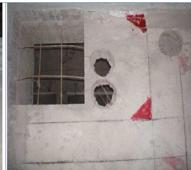
施工放线 2：管道井、烟道也须设置双控线。成品烟道和水电预留孔，在结构施工阶段，须放线定位。
