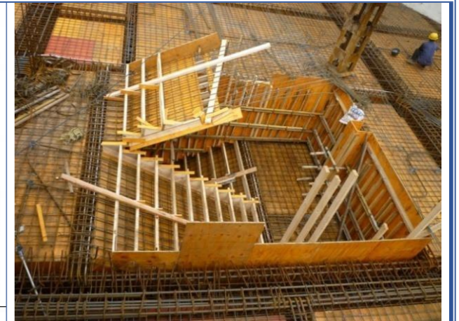
敞开式楼梯模板：楼梯采用双木方支模，能保证钢筋间距及混凝土成型质量。
