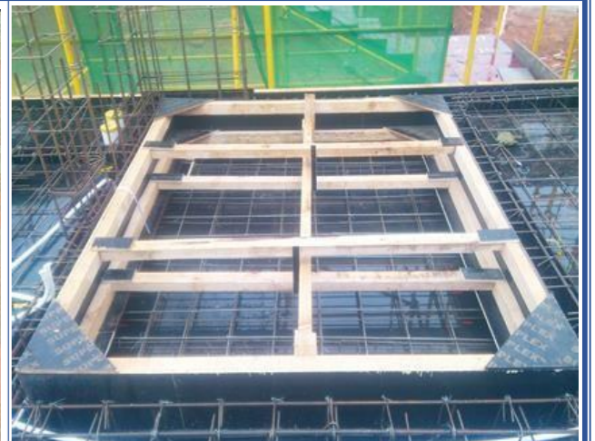
卫生间沉箱吊模：采用成品内撑确保吊模不下沉（如工程所在地质监部门有特殊规定除外）。
