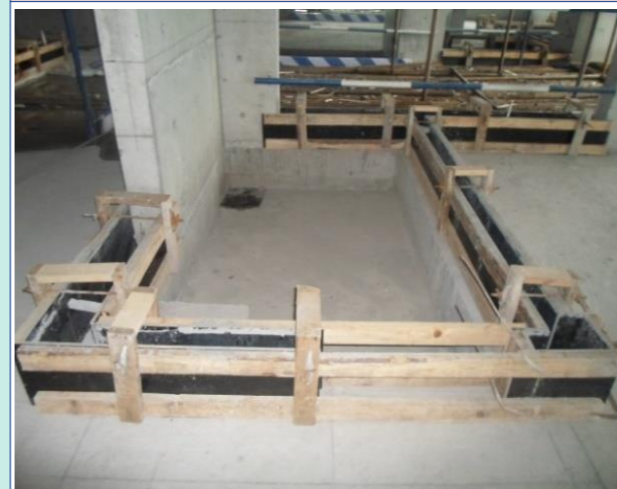
防水反坎模板支设
