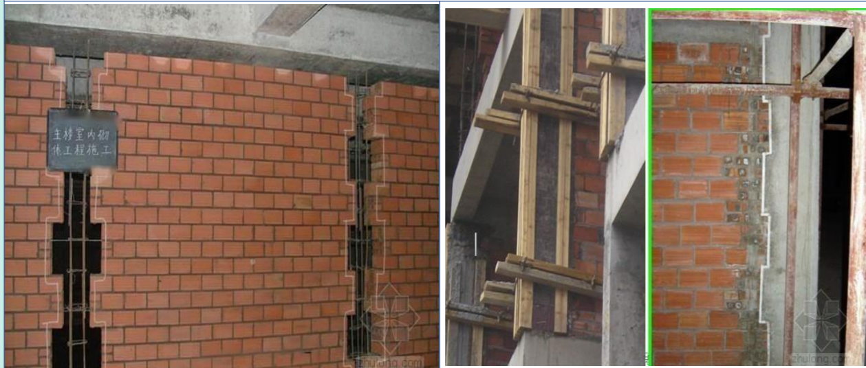
构造柱模板安装
