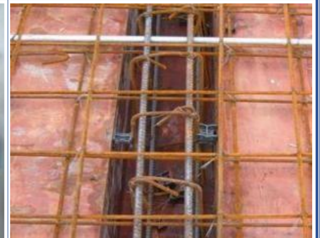
梁底及梁侧垫块：梁底及梁侧边钢筋混凝土保护层采用成品塑料分色高强垫块，梁底部及梁侧边每 1000\text{mm} 布置 2 个放在对应位置。
