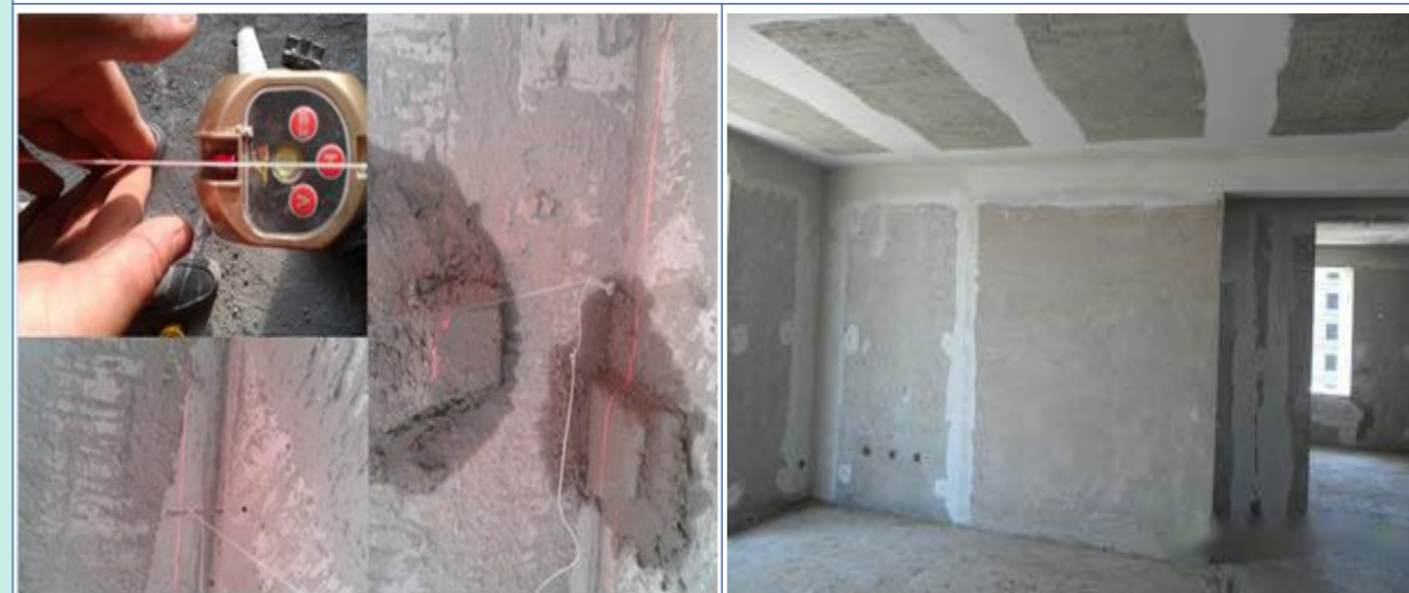
使用激光扫平仪打灰饼
