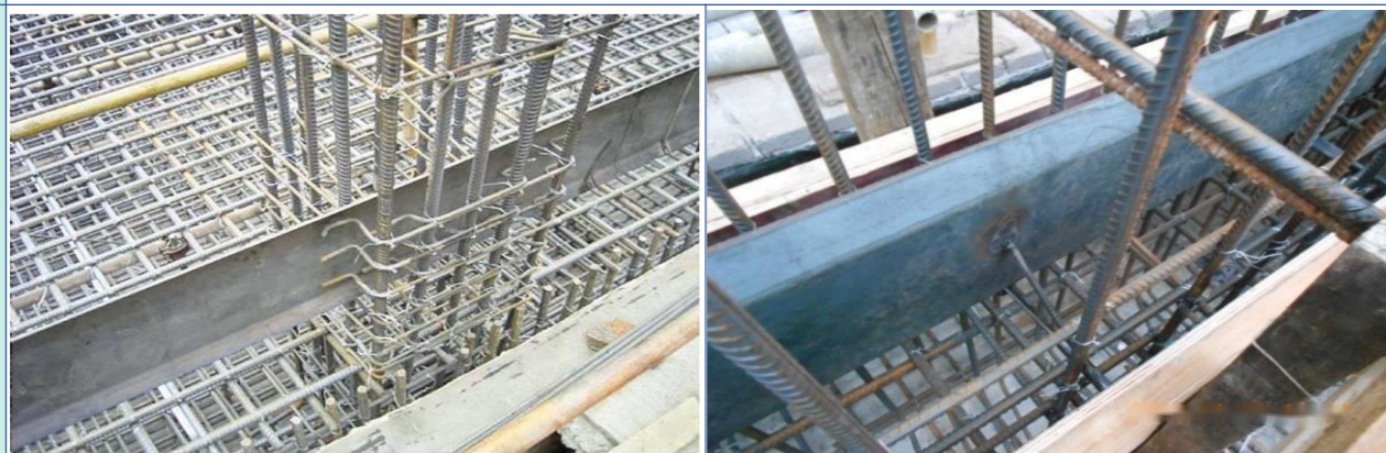
地下室外墙止水钢板与墙钢筋焊接固定
