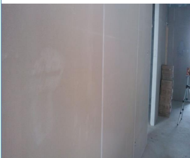
底层抹灰完成
