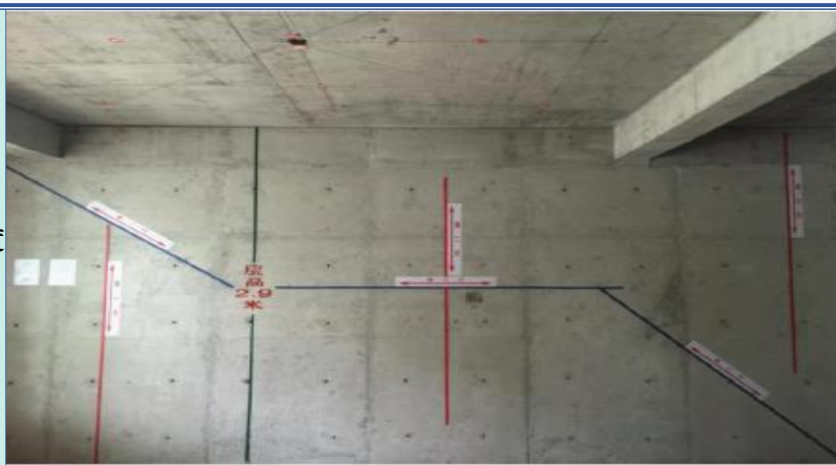
墙体垂直度、平整度测量示意
