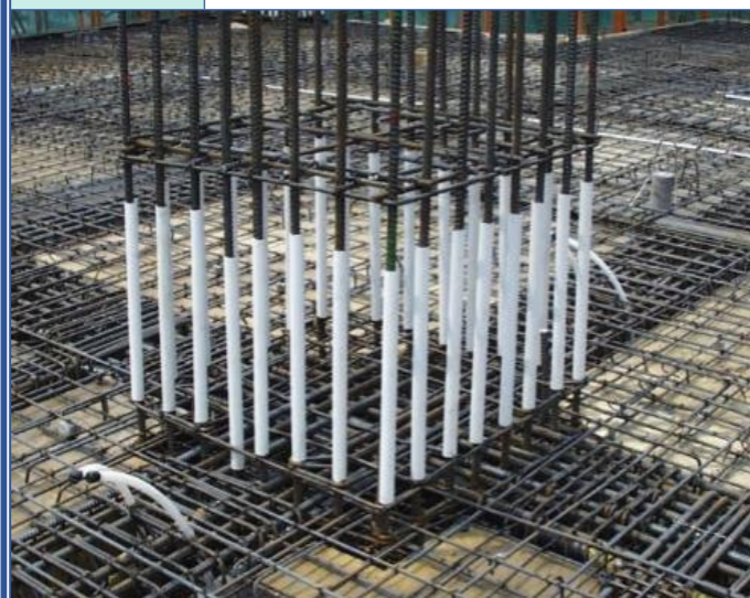
钢筋套管保护
