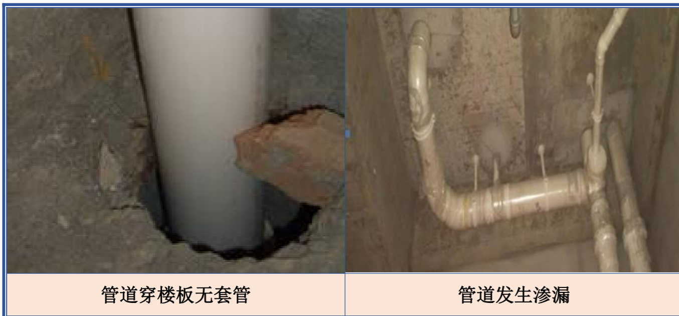
电气安装工程质量通病预防措施
