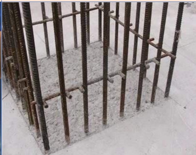
钢筋定位保护
