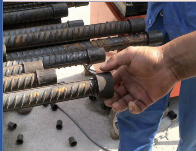
钢筋直螺纹保护
