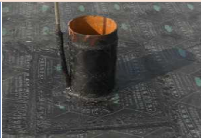
穿楼板管道防水处理
