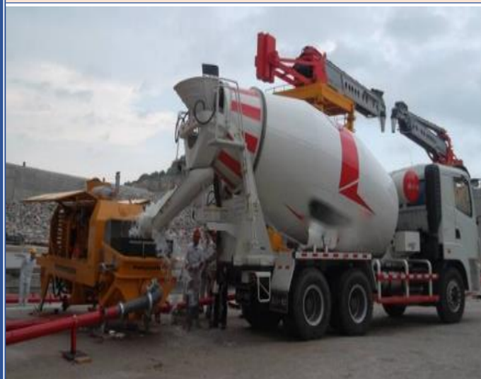
严控混凝土质量禁止混凝土浇筑加水
