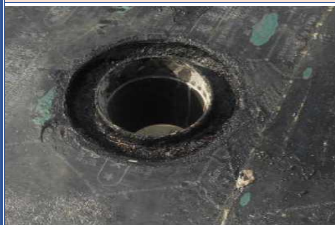
地漏防水处理
