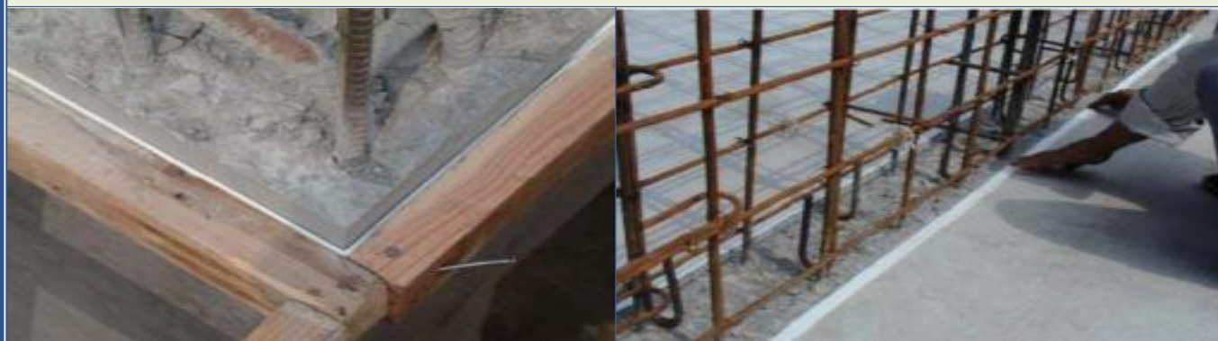
墙柱根部加设海绵条, 防止漏漏浆、烂根。
