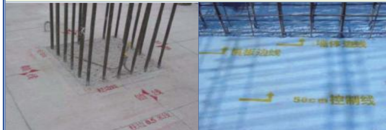
模板弹线定位, 误差控制在 1mm 以内。
