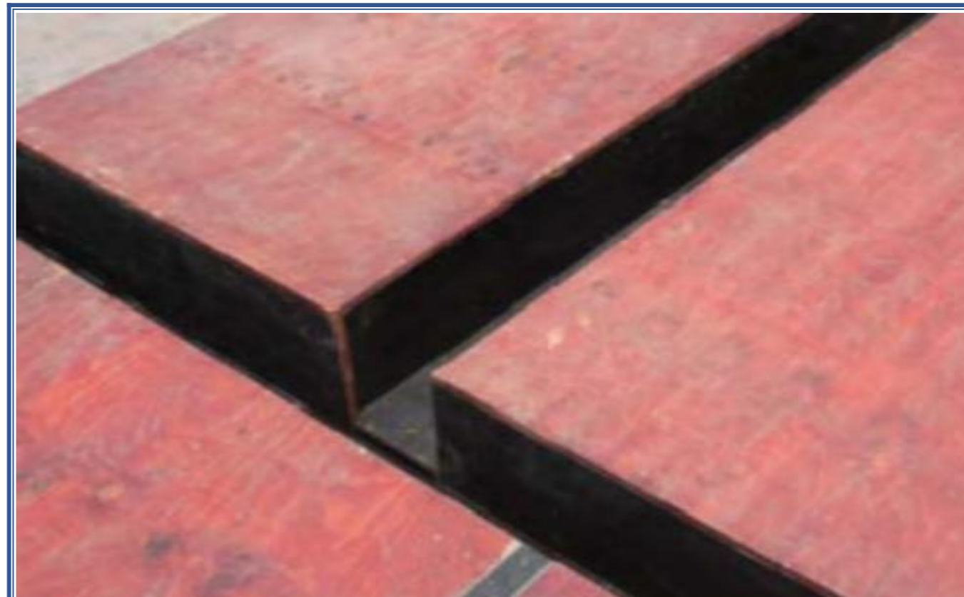
做好拼缝处理, 严格控制板面平整度。
