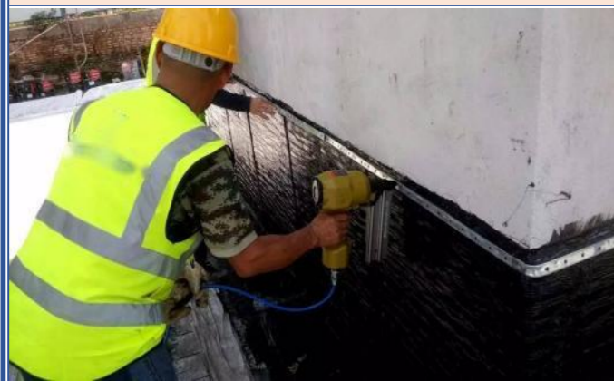
卷材铺贴收口
