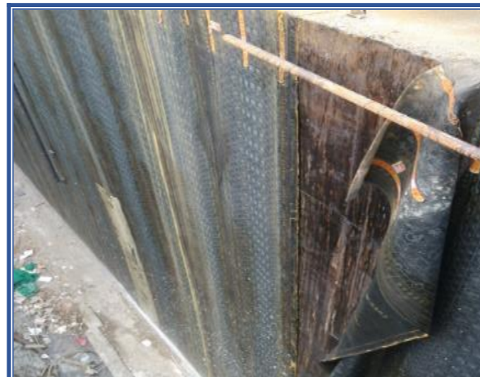
施工缝快易收口网处理
