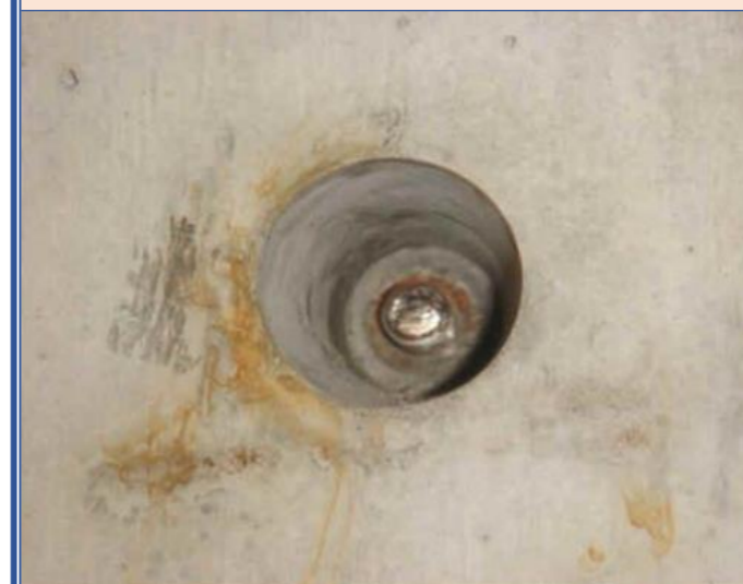
外墙止水螺杆
