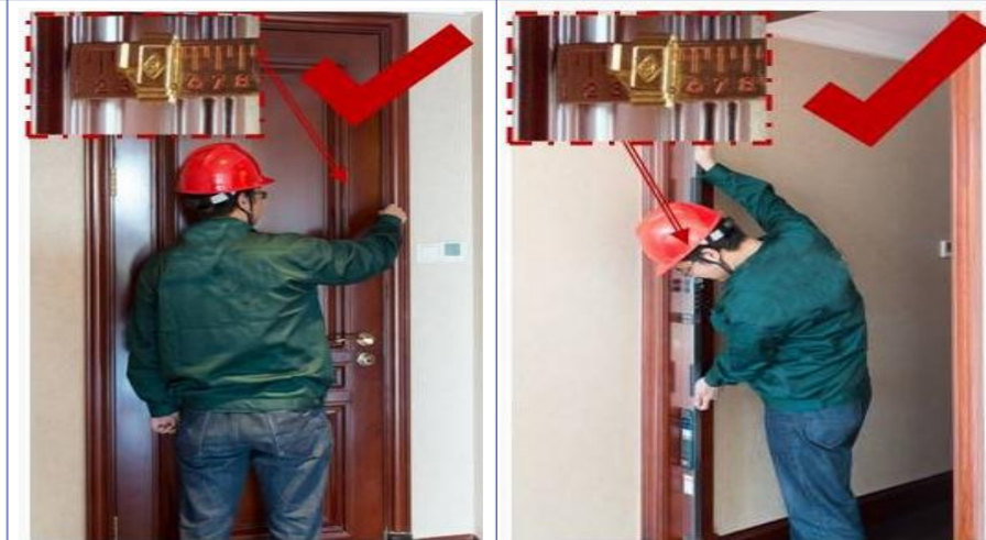
门窗框垂直度、型材拼缝
