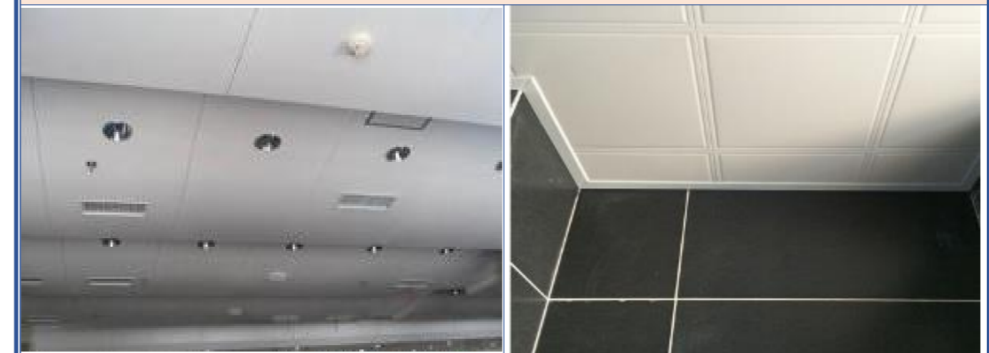
灯具、检修口、喷淋等成排成线。
