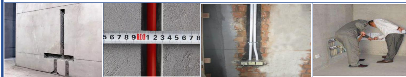
墙面给水管暗埋测量
