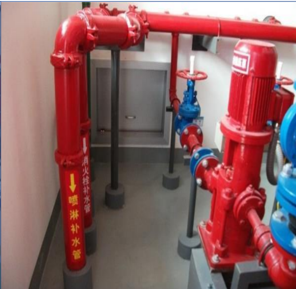
管道穿地面加套管和水泥墩
