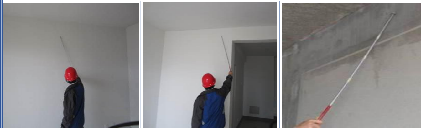
裂缝、空鼓检查
