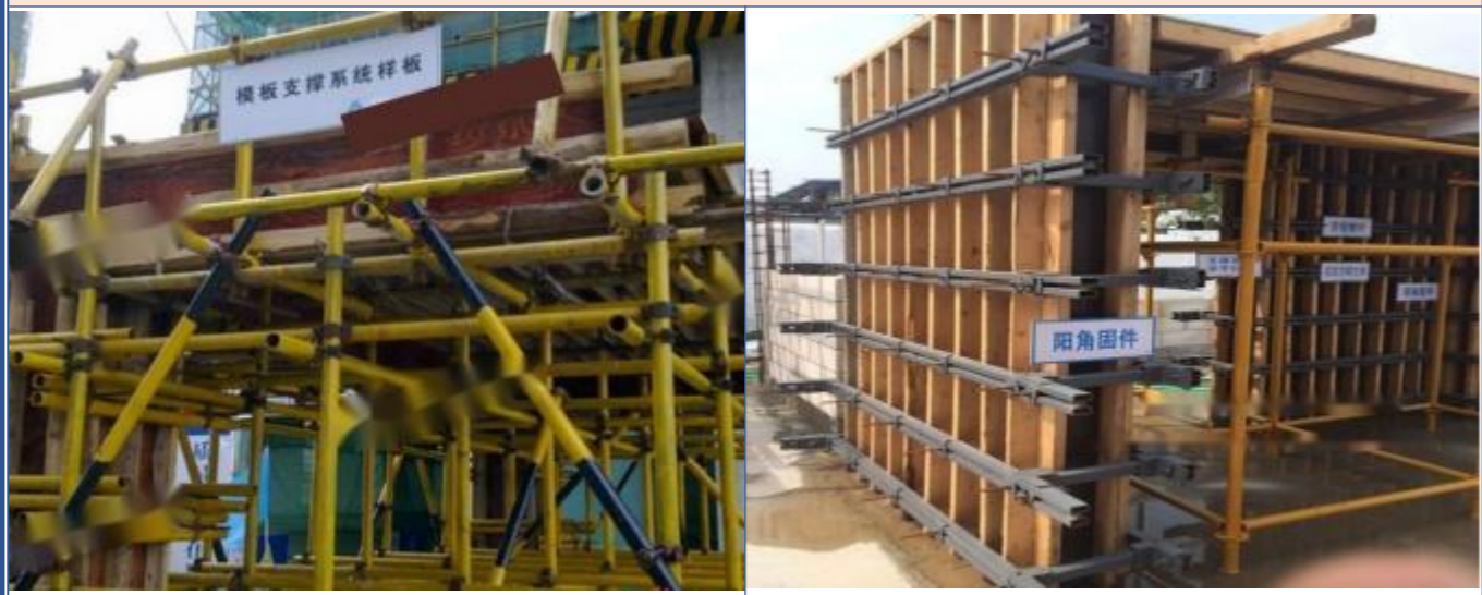
模板支撑体系样板
