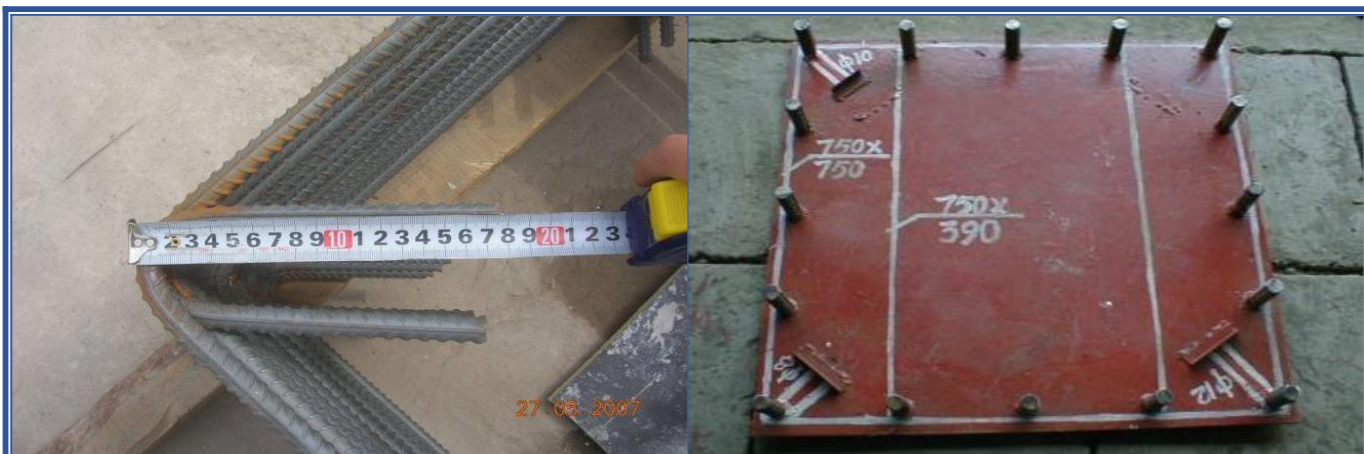
钢筋加工尺寸检查
