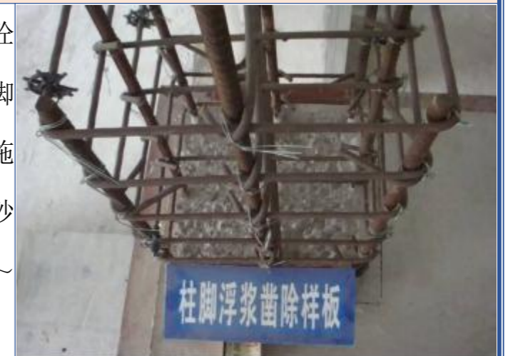
混凝土成型质量样板
