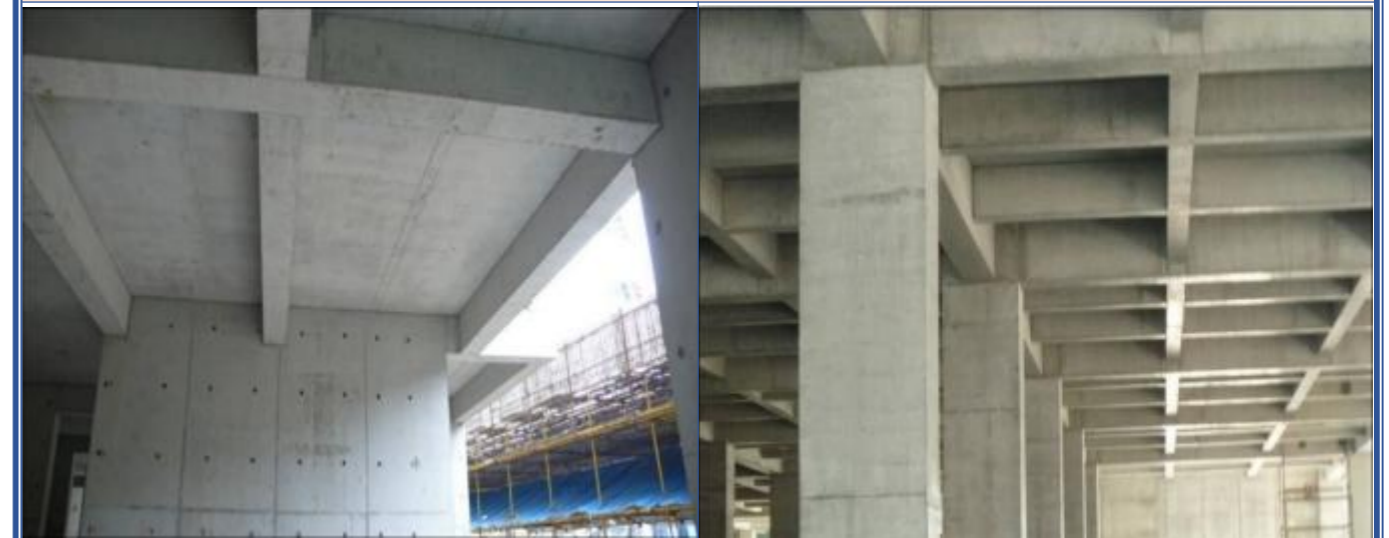
混凝土成型质量样板
