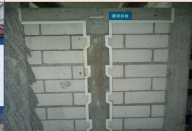
洞口侧面交接处样板
