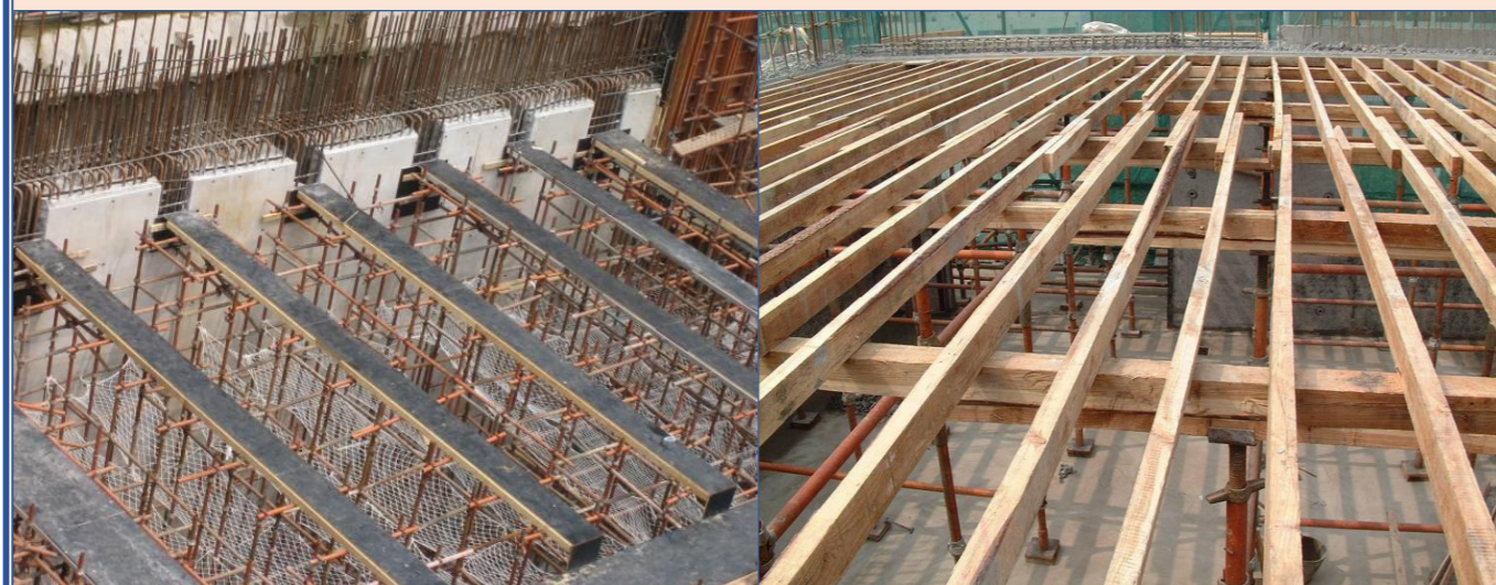
梁底模板搭设
