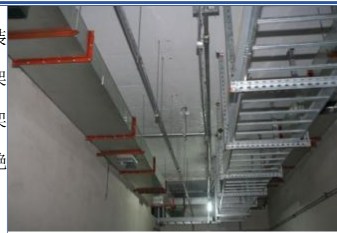
风管安装样板
