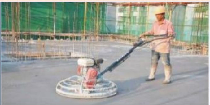
混凝土地面成型质量样板
