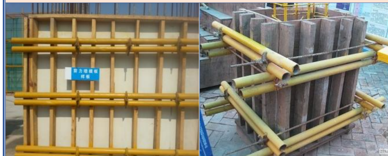
剪力墙模板样板
