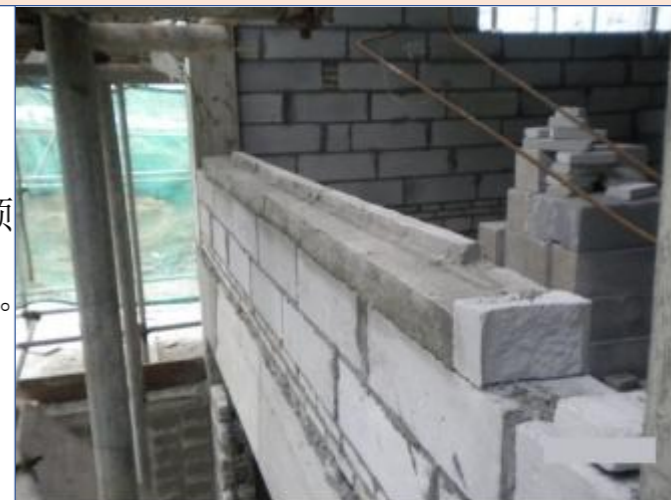
外墙线条样板
