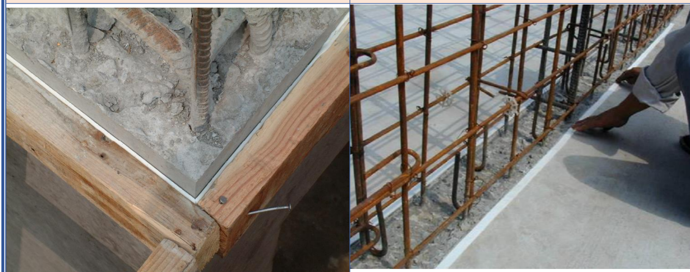
墙柱根部加设海绵条，防止漏浆、烂根
