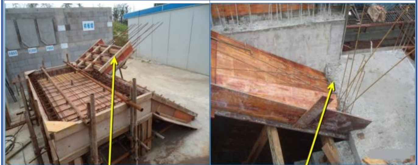
楼梯施工缝样板
