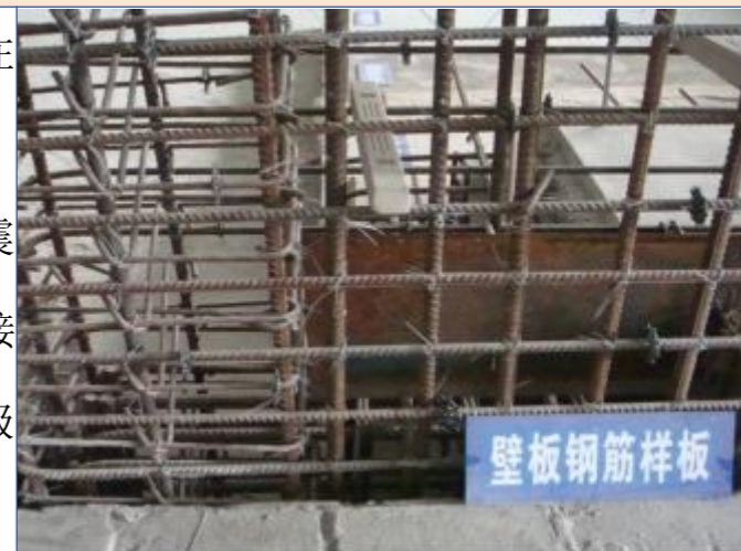
梁二排筋固定样板
