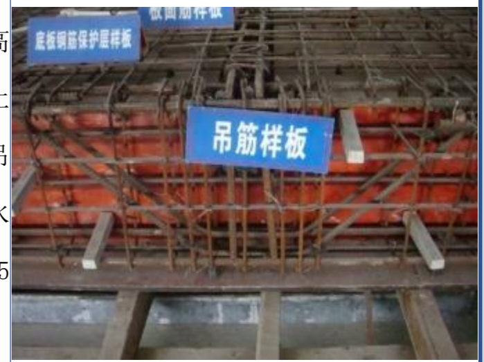
吊筋样板
