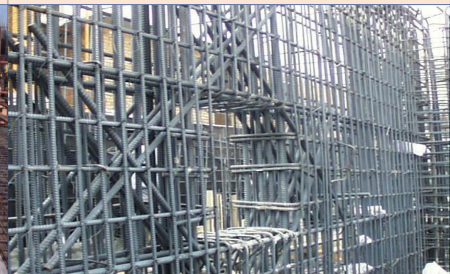
配合机电留洞, 杜绝随意切割
