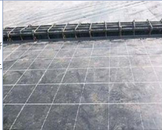
钢筋绑扎样板
