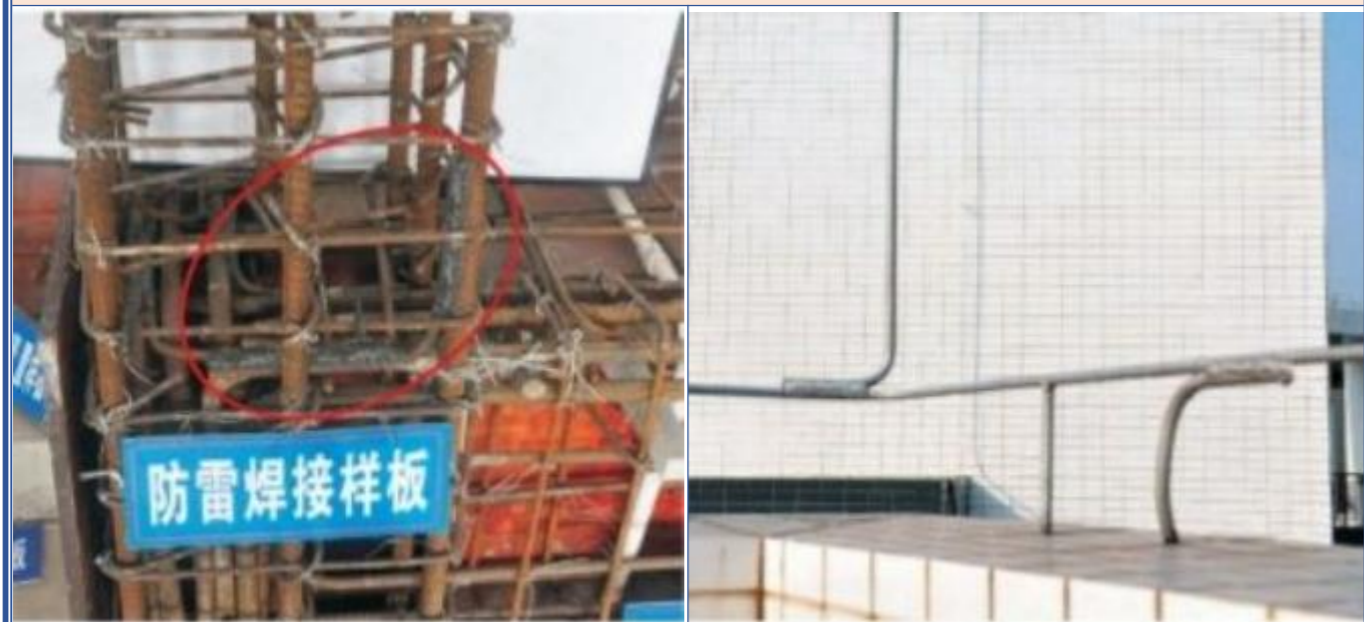
防雷焊接样板
