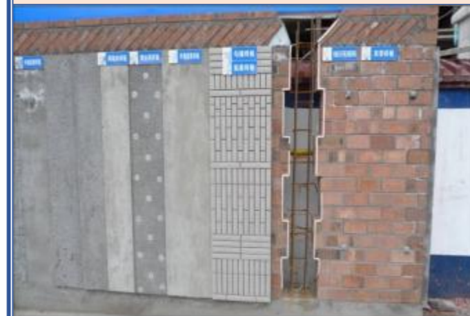
洞口侧面交接处样板
