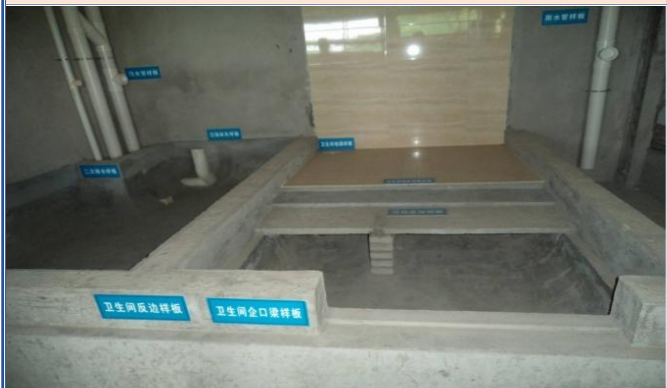
卫生间沉箱样板
