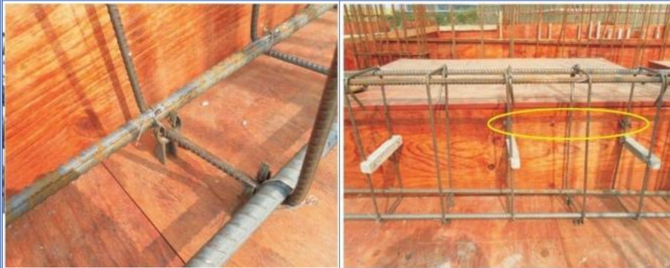
板底钢筋绑扎控制线样板
