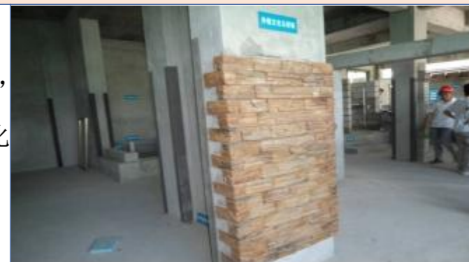
变形缝立面样板
