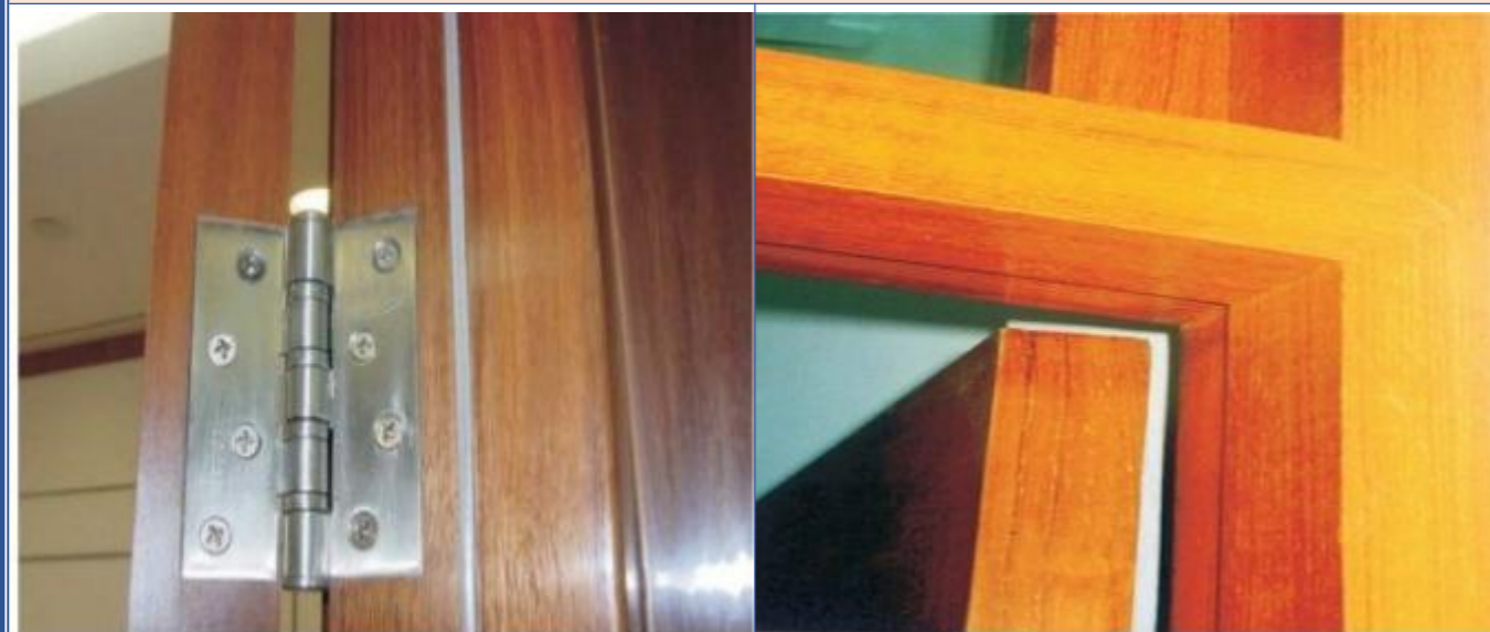
门窗固定样板
