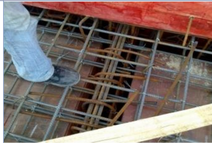
剪力墙竖向钢筋顶部弯折样板
