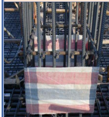
柱主筋间距控制
