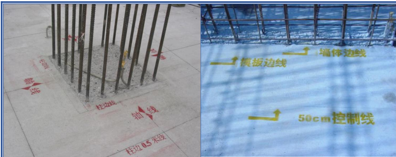
模板弹线定位，误差控制在 1mm 以内
