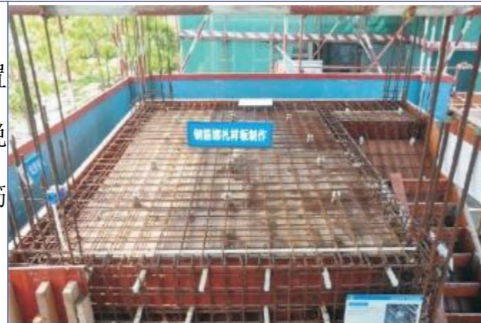
后浇带钢筋构造样板
