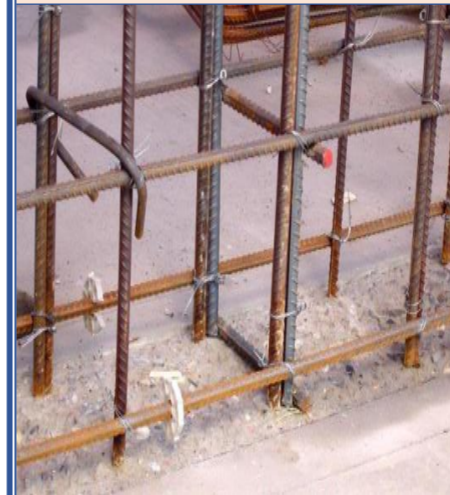
剪力墙水平筋间距控制
