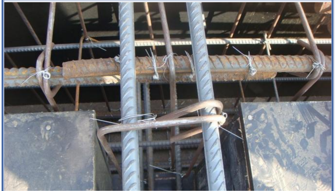
—剪力墙水平钢筋端部弯折样板
