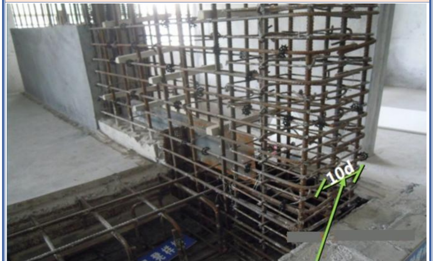
—剪力墙水平钢筋端部弯折样板
