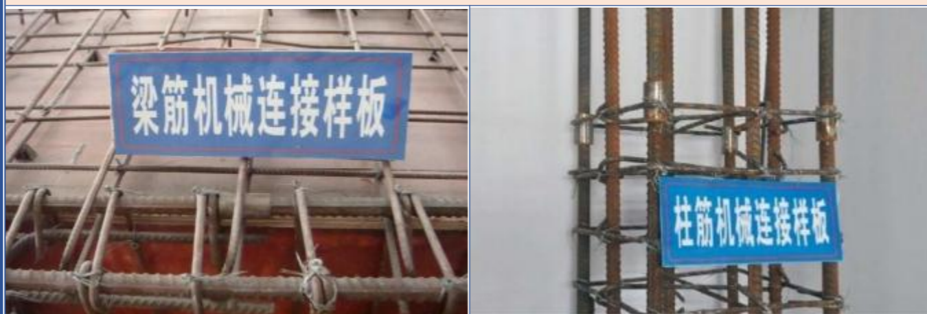
梁柱筋机械连接样板
