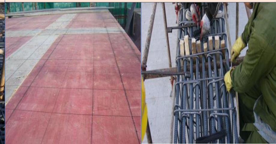
梁板钢筋控制
