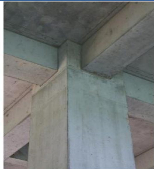
混凝土梁、板、柱节点清晰，棱角方正
