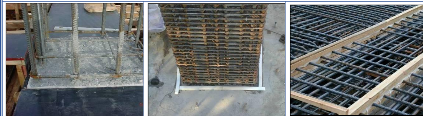
柱模板安装前预处理
