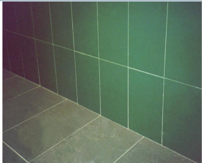
地砖与墙面砖隔块对缝
