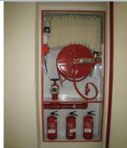
箱式消火栓安装：栓口朝外安装在开门侧，栓口中心距地面为1.1m，允许偏差±20mm；水带盘法和接口绑扎正确，箱体四周封堵严密，门上标识齐全，有便于开、关的手柄。
