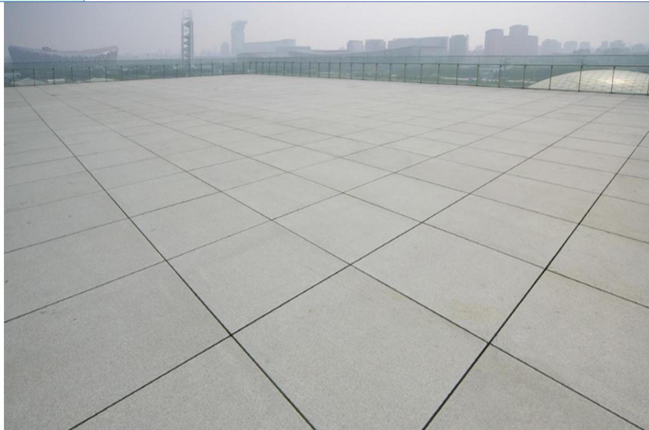
屋面坡向正确，排水流畅，细部做法细致规范。
