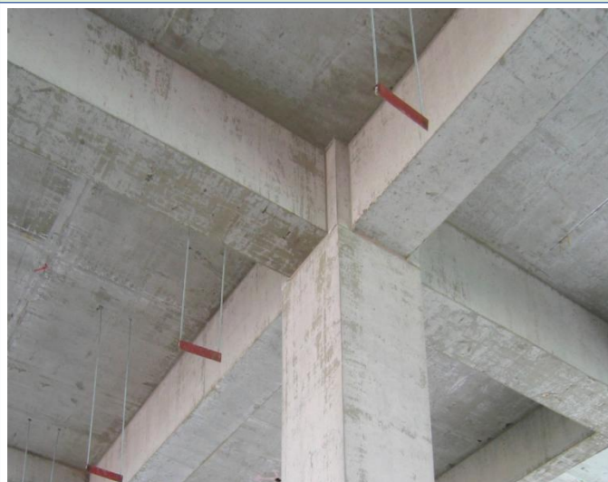
混凝土结构内实外光，截面尺寸准确；梁柱接头方正，棱角顺直。
