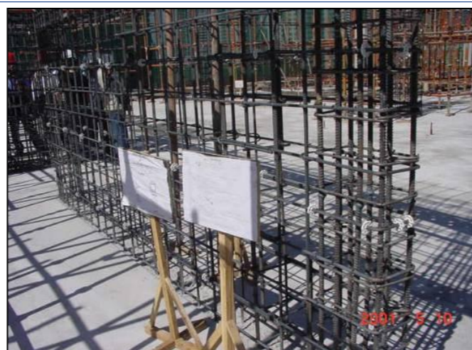
混凝土剪力墙样板
