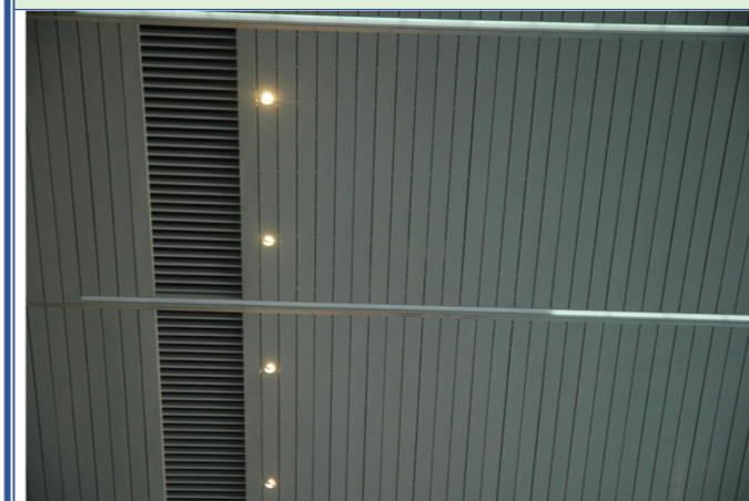
弧度圆滑一致、表面平整、起槽处宽窄深度一致
