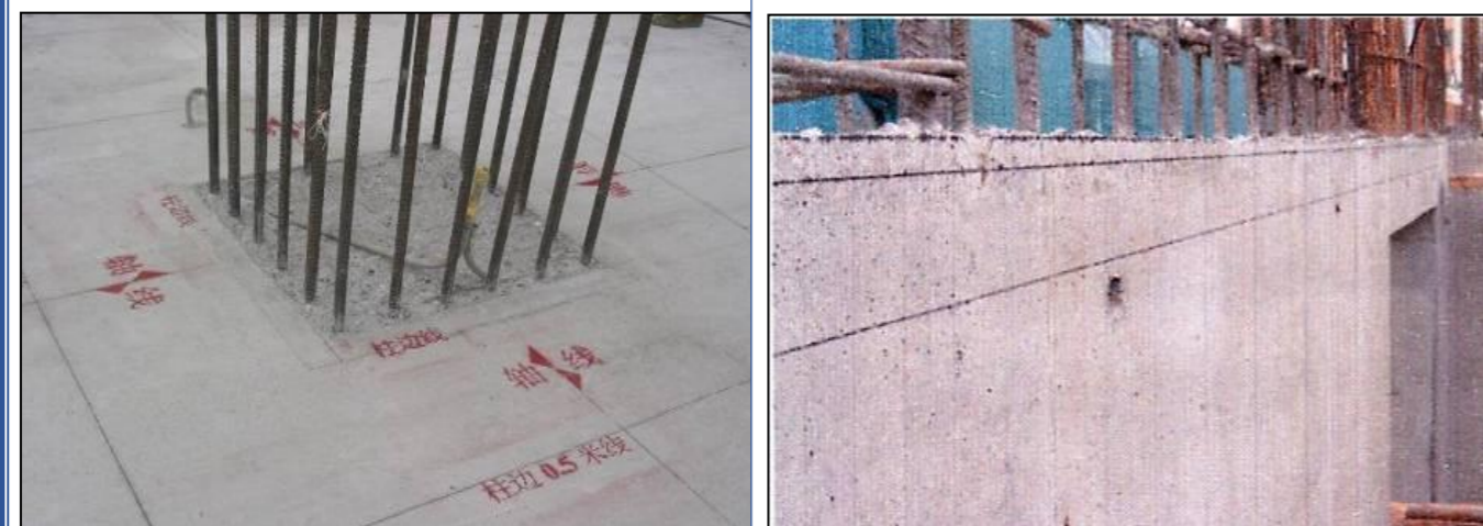
弹柱边线、切边、剔除软弱层
