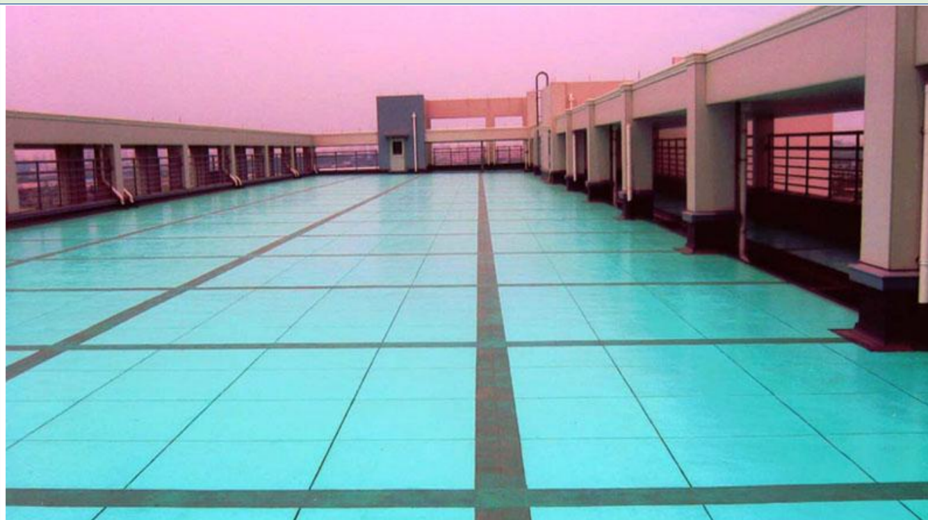
上人屋面表面平整、坡度符合要求，分缝合理
