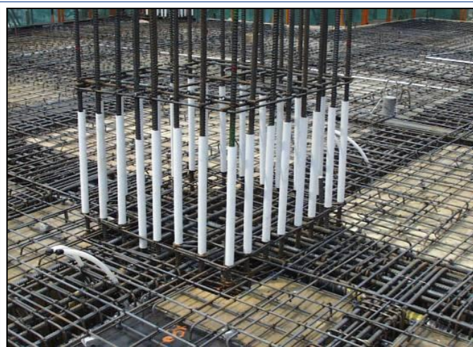
混凝土浇筑前对柱筋防污染的措施
