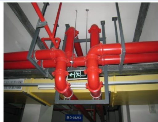
管道上、下返及转弯处均设置支架，安装规范牢固，工艺精细
