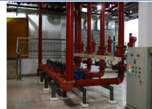
湿式报警阀控制模块设置在桥架上，安装合理、牢固。卡箱式连接管道及阀门支架设置位置正确，制作安装工艺精细
