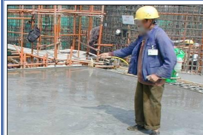
楼板喷水养护
