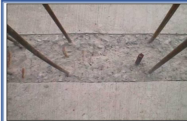
墙体下口与楼板交接处软弱层剔除
