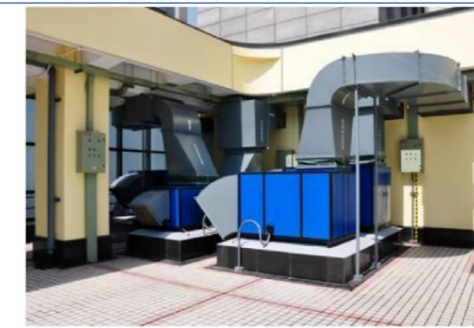
风机、风管、电箱、桥架等设施安装规范，进风口设置向下弯头，风管上返处设置支架，电源进线管设置全柄弯，与屋面、柱及构架梁装饰协调
