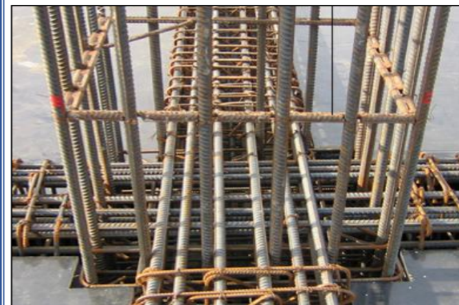
梁柱接头钢筋绑扎
