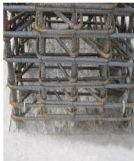
柱接槎处浮浆清理，表面凿毛，增加混凝土结合力
