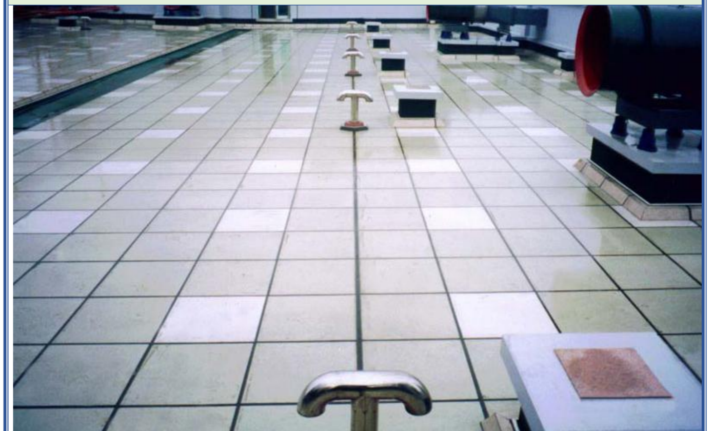
屋面不锈钢排气管布置成排成线
