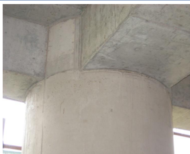
主体结构截面尺寸准确，棱角分明，线条顺直
