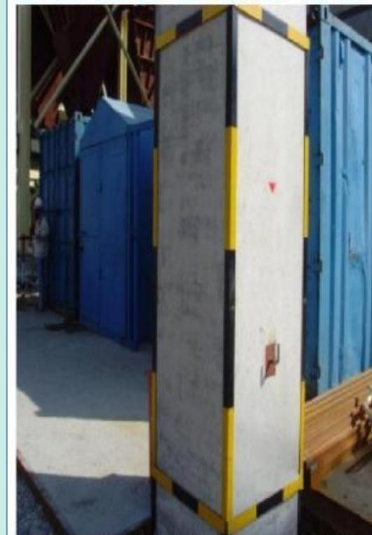
柱周边用废旧模板包角，油漆涂刷醒目
