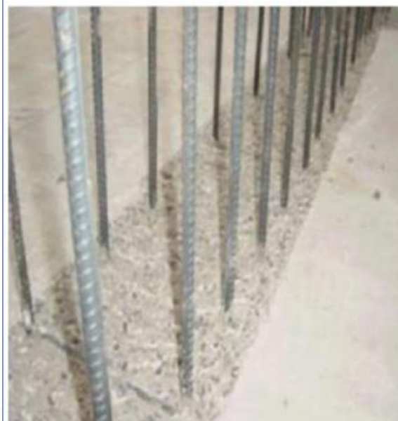
剪力墙凿去根部浮浆，墙根切割齐整
