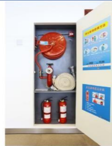
箱式消火栓安装：栓口朝外安装在开门侧，栓口中心距地面为1.1m，允许偏差±20mm；水带盘法和接口绑扎正确，箱体四周封堵严密，门上标识齐全，有便于开、关的手柄。
