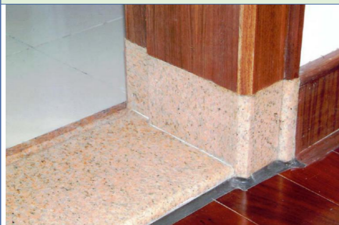
卫生间木门套下脚采用花岗岩踢脚线防潮
