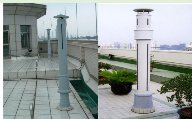
造型美观的屋面通风管
