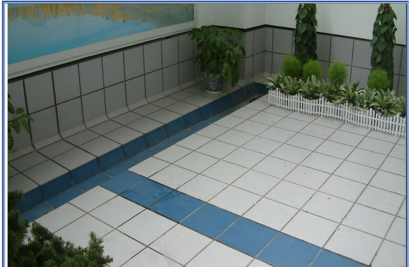
花园屋面面砖平整方正，泛水部位面砖镶贴高度一致
