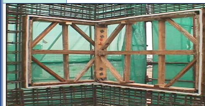
加海绵条防止漏浆
