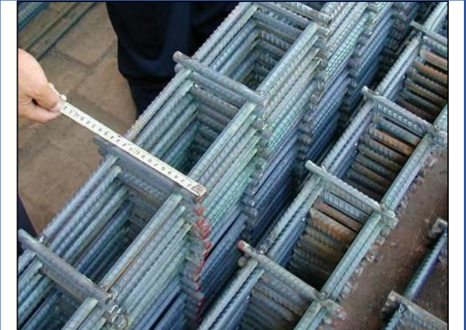
严格控制钢筋半成品加工质量
