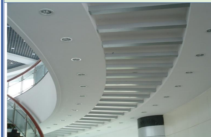
弧度圆滑一致、表面平整、起槽处宽窄深度一致
