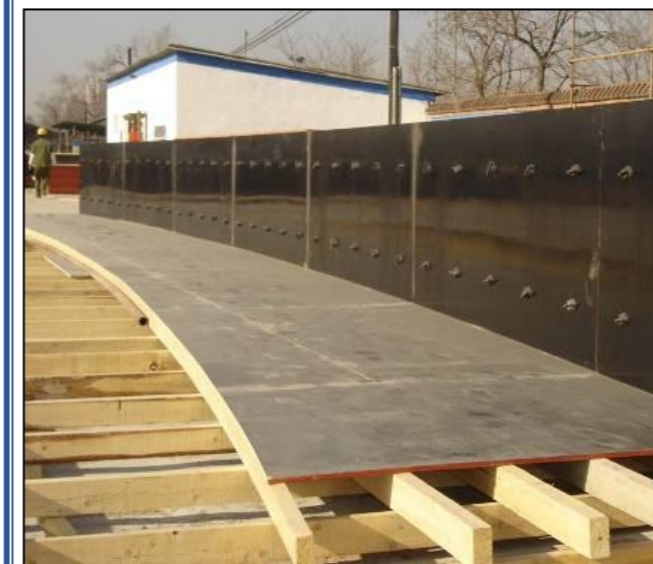
拼缝严密、阴阳角顺直,无错台及变形
