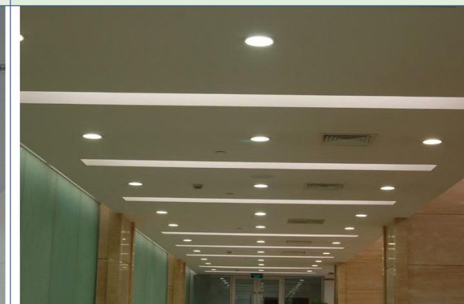
吊顶设计美观，构造合理、施工精细
