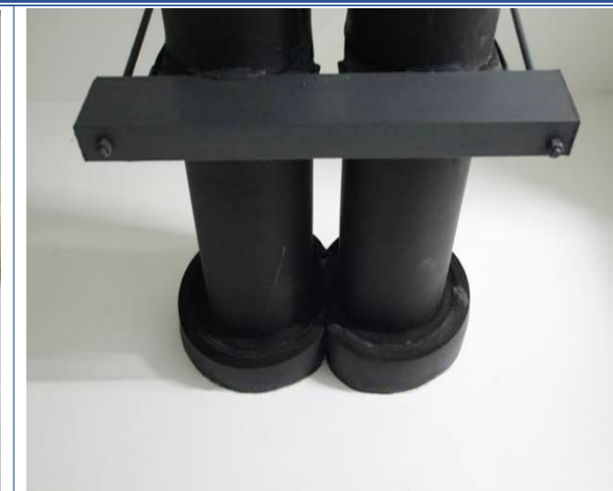
穿墙及穿楼板套管与管道安装同心
