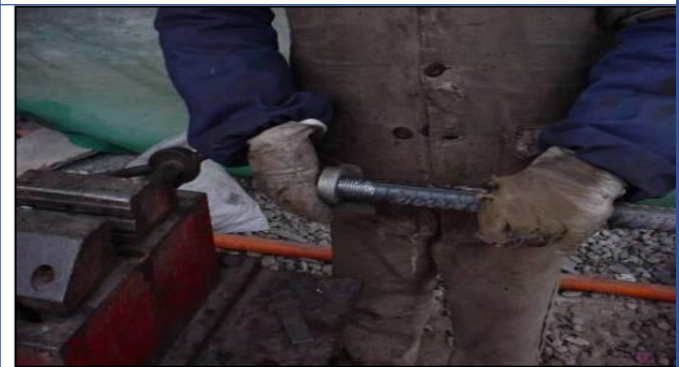
钢筋绑扎搭接接头，焊接连接接头（电弧焊、闪光对焊、电渣压力焊）和机械
