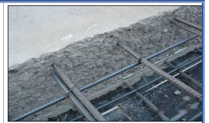
施工缝剔毛至石子
