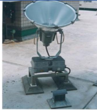
屋面反光照明灯安装工艺细腻、接地可靠、防水严密
