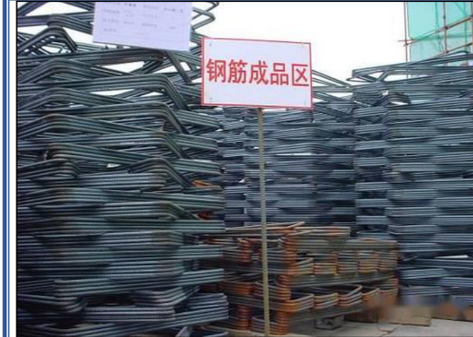
严格控制钢筋半成品加工质量
