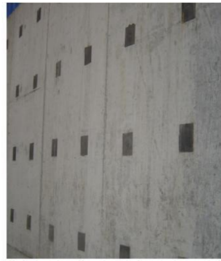
混凝土剪力墙垂直平整，表面密实、光洁，无蜂窝、麻面
