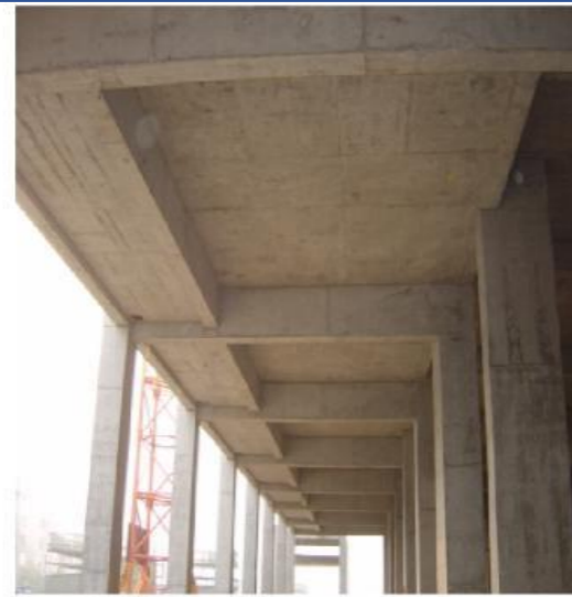
梁、柱混凝土构件成线，截面尺寸准确
