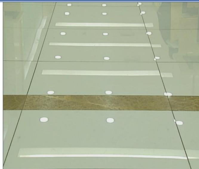
玻化砖地面拼缝严密，平整
