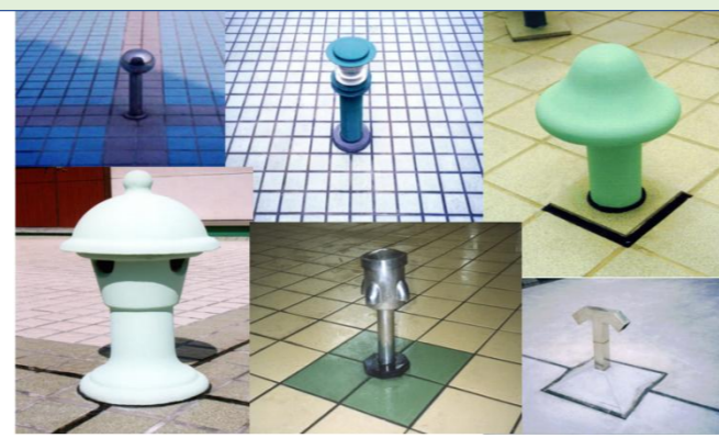
形式多样的屋面排气孔盖
