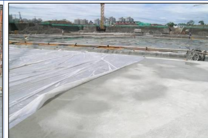
加塑料薄膜覆盖养护
