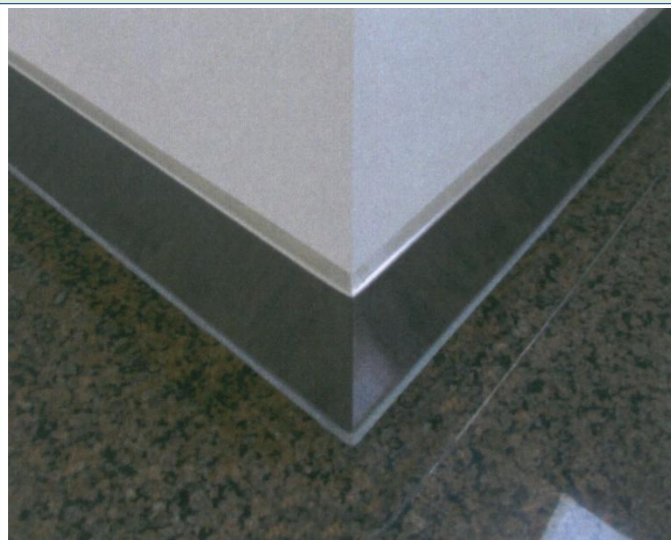
金属踢脚线出墙一致、美观
