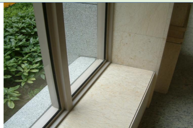
窗周密封严实，窗台坡度正确，有效阻止窗周渗漏
