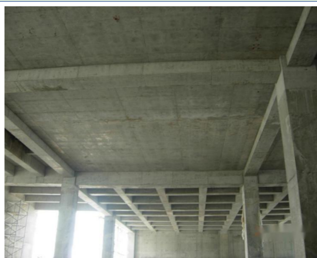
混凝土结构内实外光，截面尺寸准确；梁柱接头方正，棱角顺直。
