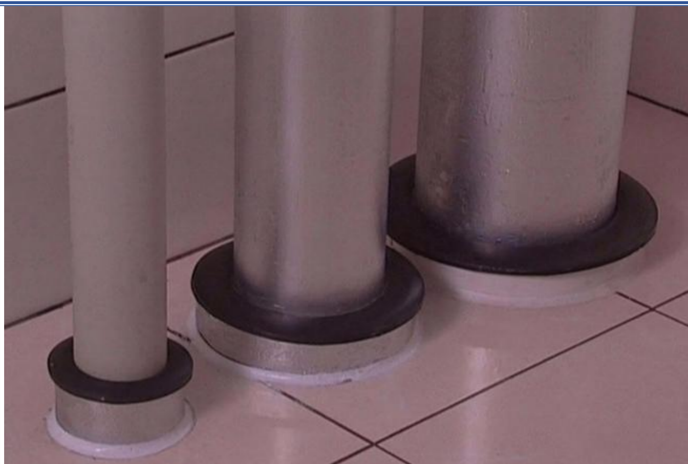
管道在地面处的护口
