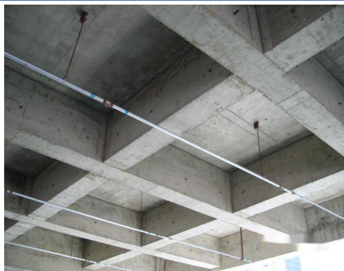
主体结构截面尺寸准确，棱角分明，线条顺直
