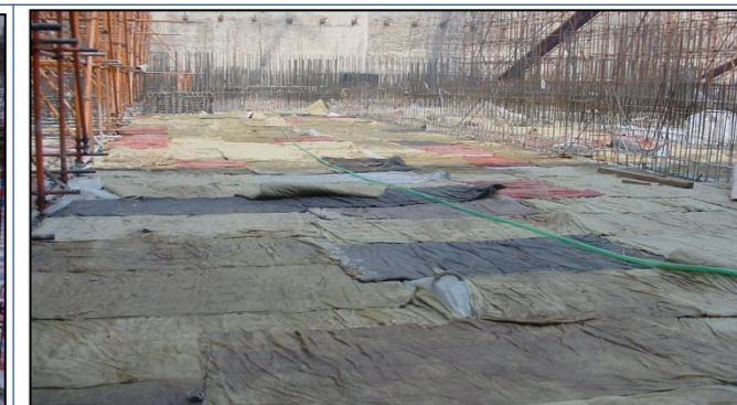
混凝土保水、保温养护
