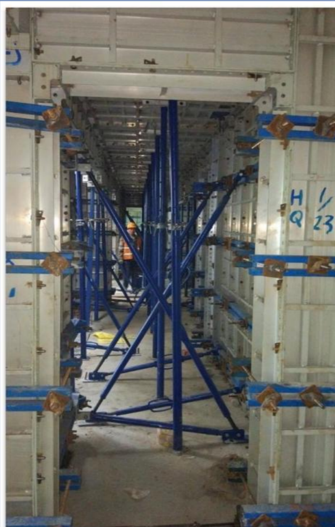
图 4-3 穿墙螺杆体系-支撑体系
