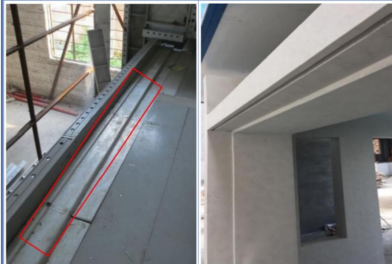
凹槽滴水线模板图
