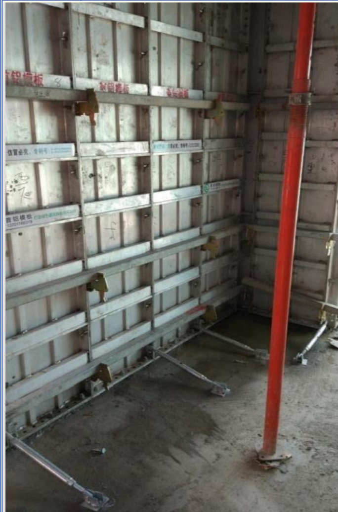
图 4-2 对拉片体系-支撑体系
