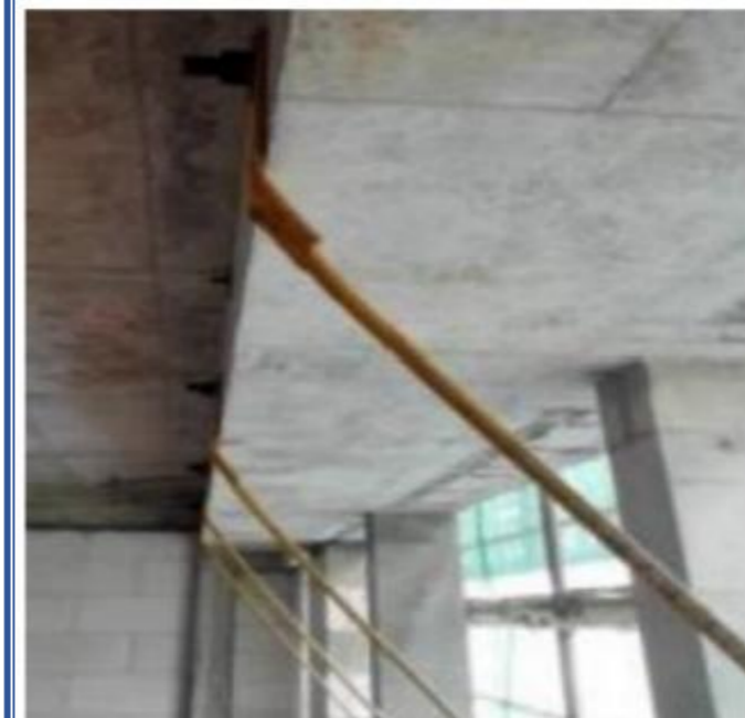
拉杆不穿楼板连接示意图
