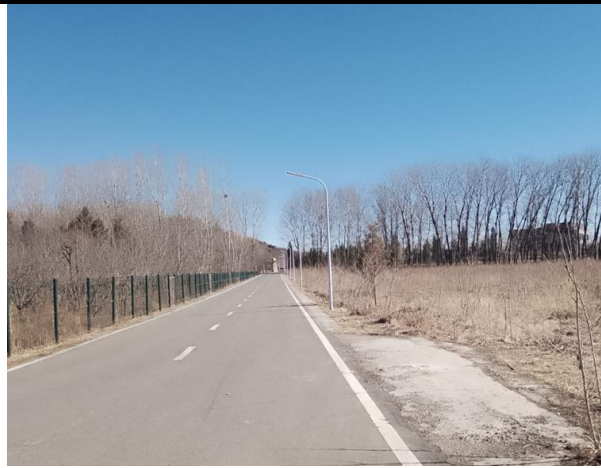
水厂南侧向东
