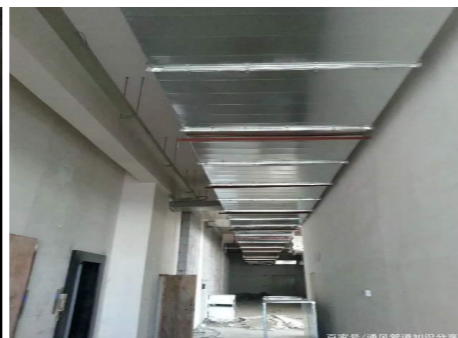
风管安装完成效果
