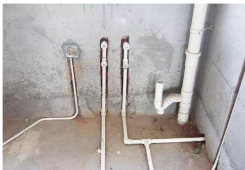
给水管道安装
