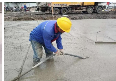
混凝土振捣
