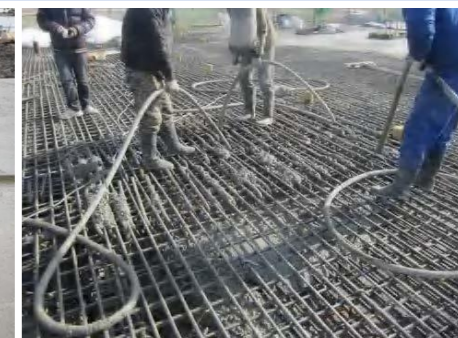
混凝土浇筑
