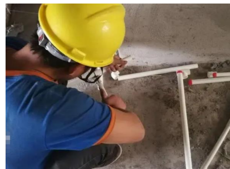
给水管道安装
