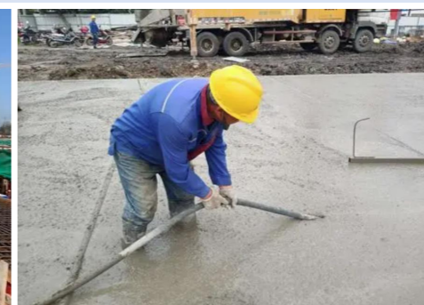
混凝土振捣
