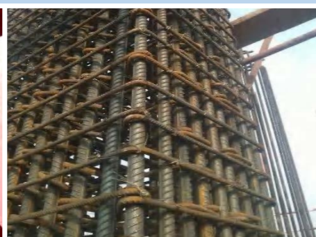
钢筋绑扎控制
