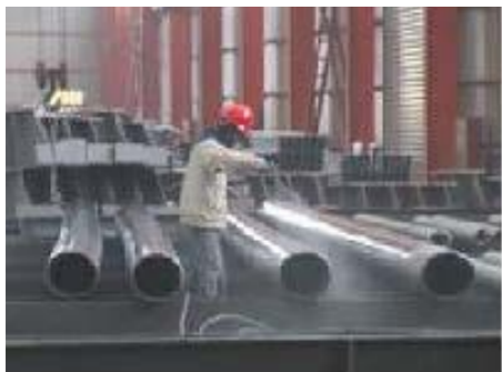
加工厂防腐底漆涂
