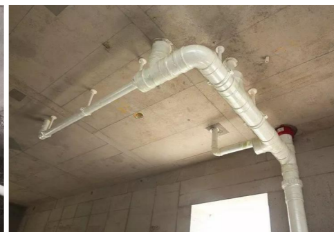
排水管安装完毕效果
