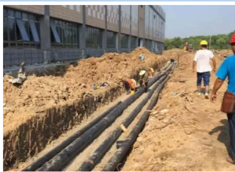
室外给水管道施工
