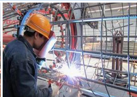
钢筋接头焊接
