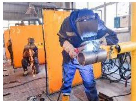
焊接防护措施
