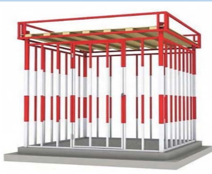
配电箱防护棚
