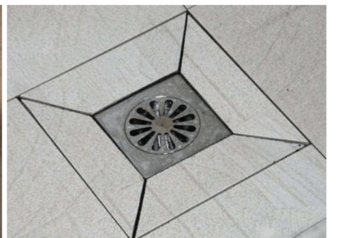
地漏安装完毕效果
