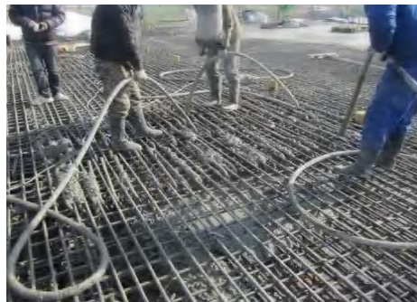
混凝土浇筑
