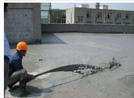
泡沫混凝土找坡
