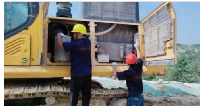
施工机械检查
