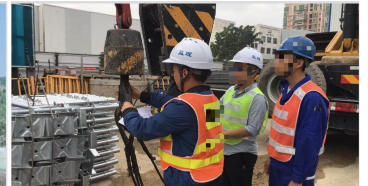
施工机械进场验收
