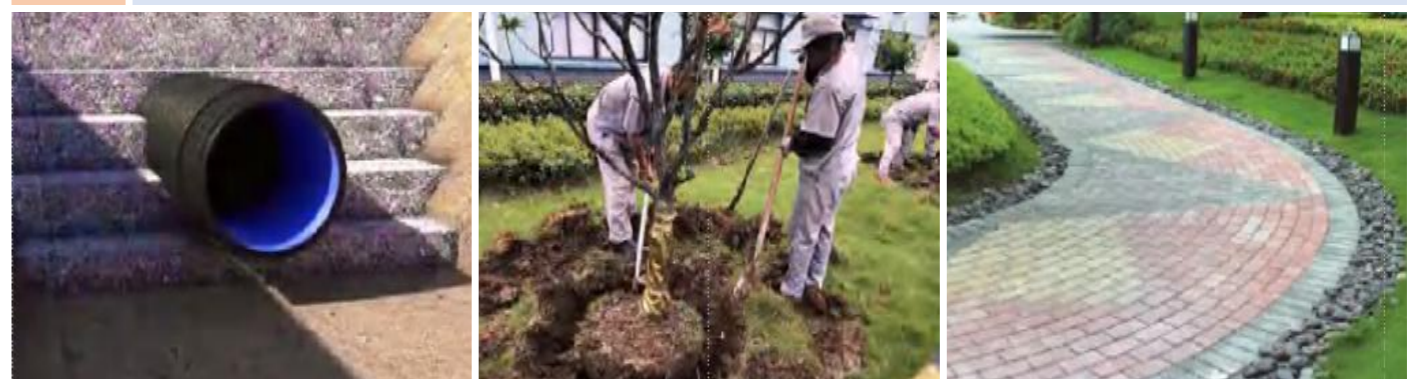
管道分层回填
