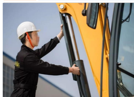
施工机具修理
