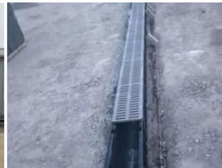
雨季施工排水通畅
