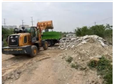
建筑垃圾清理
