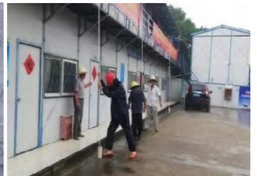
办公区加固防台风
