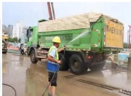
渣土覆盖运输
