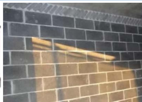
顶部斜砖砌筑效果
