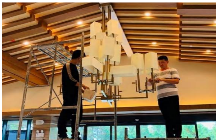
室内灯具安装
