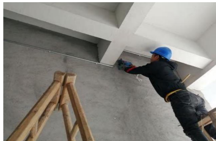
弱电配管穿线
