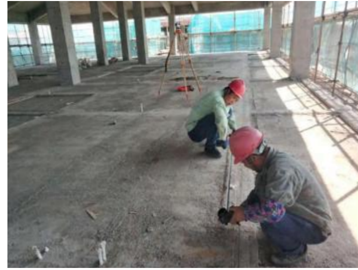
墙体测量放线
