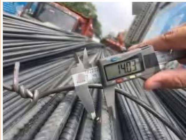
钢筋进场检查
