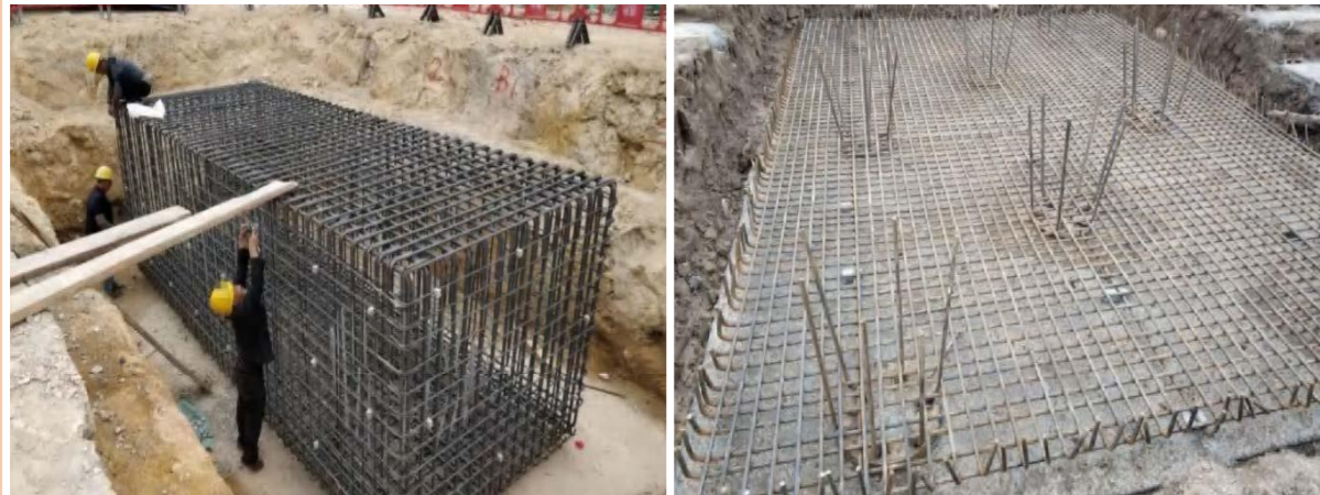
承台钢筋绑扎
