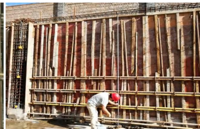
剪力墙模板安装
