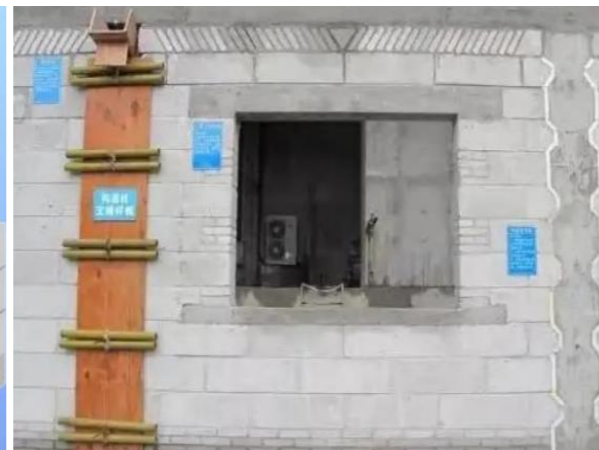
门窗洞口过梁
