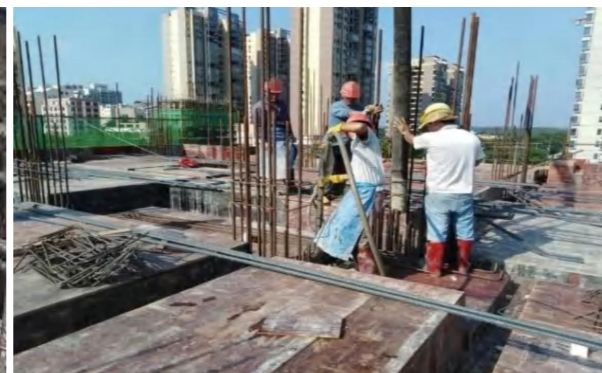
墙柱砼浇筑
